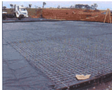
Imagem 27 - Pavimento em betão armado.
