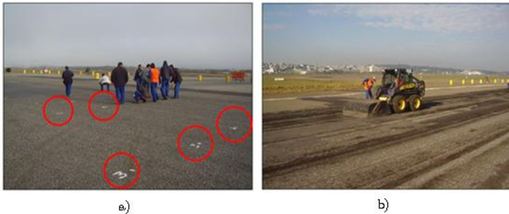
Imagem 29 - Sequência de passos para a fresagem. a) Exemplo de espessuras de fresagem. b) Exemplo de remoção do material fresado.
