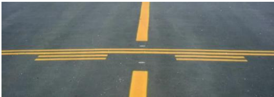
Imagem 77 - Sinalização do ponto de espera.
