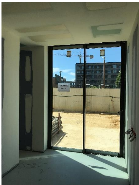
Figura 4.23 – Caixilharia no Piso 0 (Autor do trabalho)
