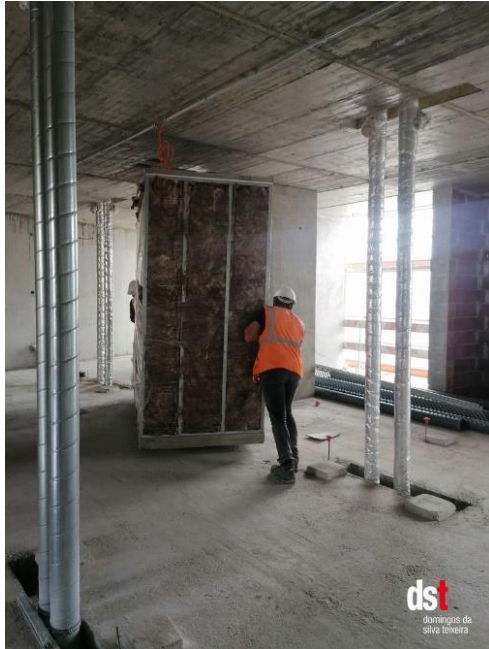
Figura 4.4 – Colocação dos monoblocos (DST, S.A., 2022)
