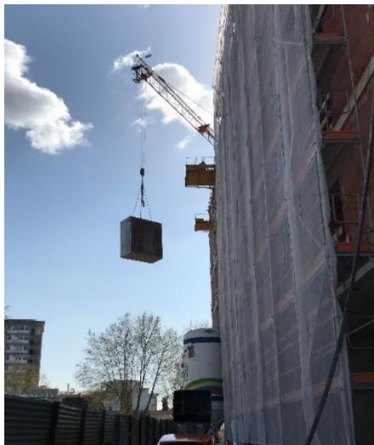
Figura 3.5 – Elevação de uma casa de banho em monobloco (Autor do trabalho)
