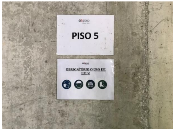
Figura 3.17 – Exemplo de sinalização no estaleiro (Autor do trabalho)
