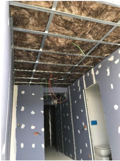
Figura 4.21 – Estrutura do teto (Autor do trabalho)
