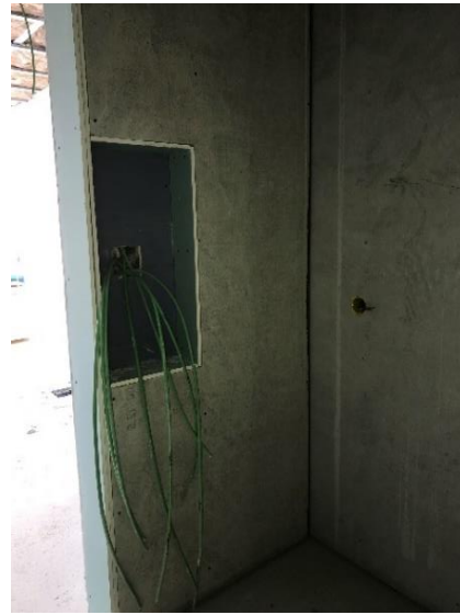
Figura 4.22 – Preparação para colocação do quadro elétrico (Autor do trabalho)
