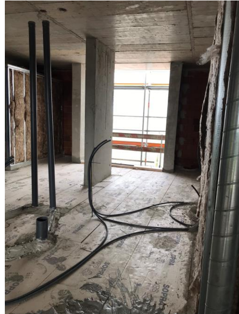
Figura 4.5 – Piso revestido com XPS (Autor)
