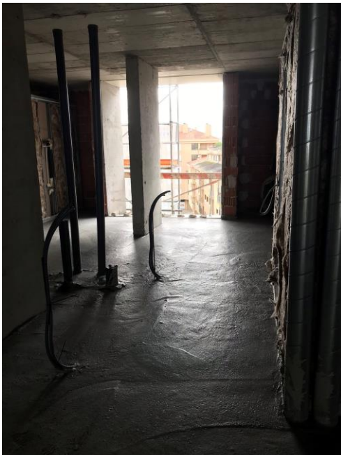
Figura 4.6 - Colocação da camada de betão leve (Autor)
