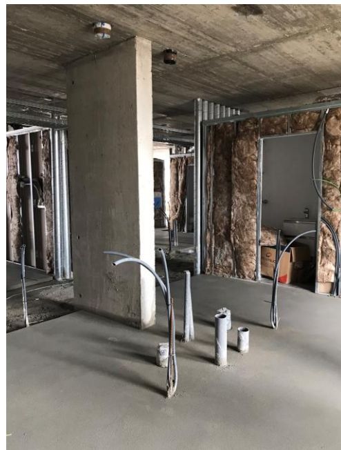
Figura 4.7 - Execução do piso em betonilha (Autor)
