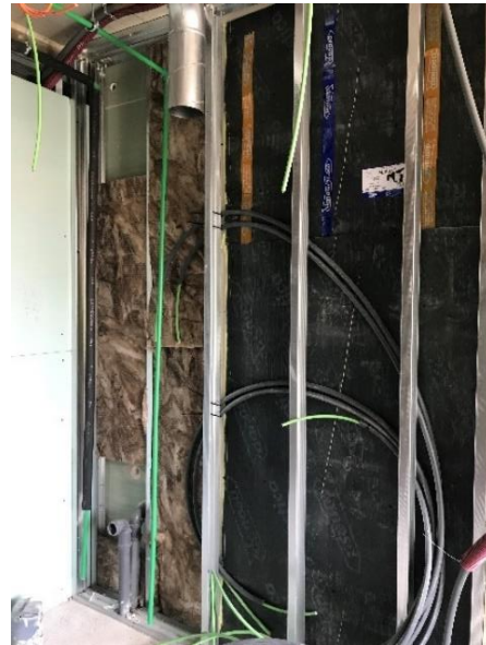
Figura 4.19 - Fase 2: Colocação da placa intermédia e tela acústica (Autor do trabalho)
