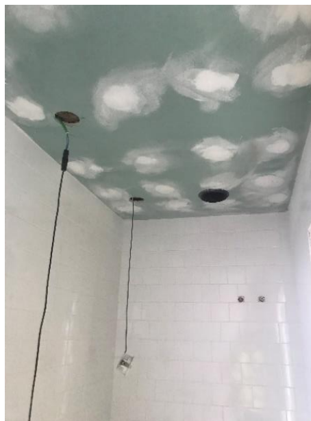
Figura 4.24 – Teto por pintar num WC modular (Autor do trabalho)
