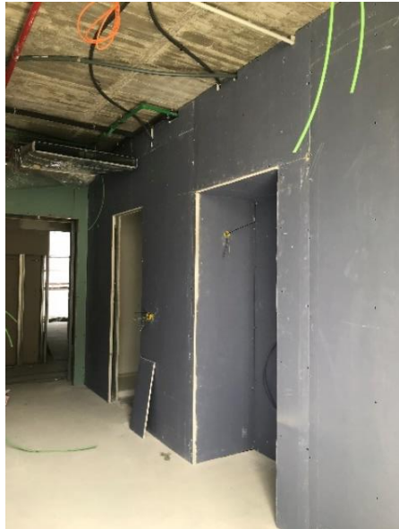
Figura 4.18 - Revestimento da frente da casa de banho (Autor do trabalho)
