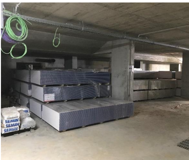
Figura 3.11 – Armazenamento de material no piso da cave (Autor do trabalho)
