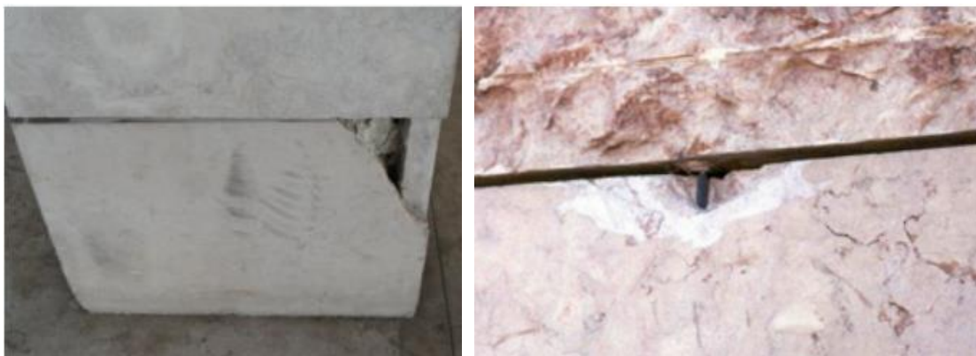
Figura 3.12 – Lascagem das placas de pedra natural na zona das ancoragens. (Lourenço, [s.d.]; Silva, 2009)
