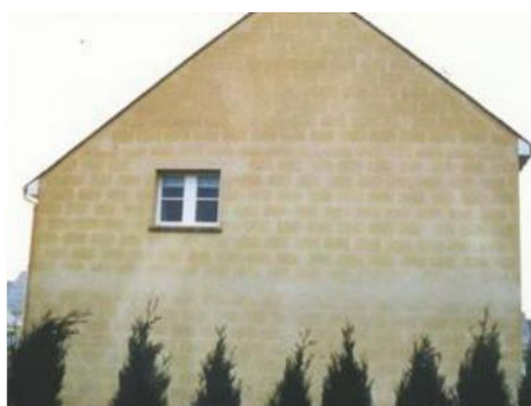
Figura 3.17 – Exemplo de um espetro ou fantasma na fachada de um edifício. (Lourenço, [s.d.])
