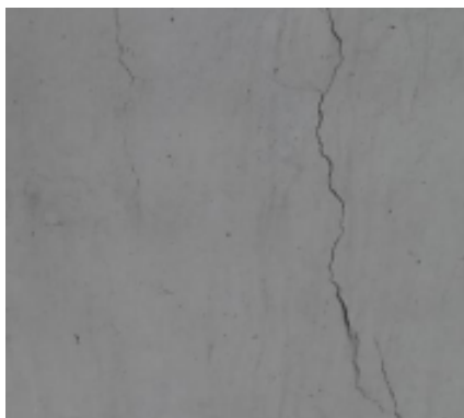
Figura 3.46 – Exemplo de fissuração direcionada. (Coelho, 2015)
