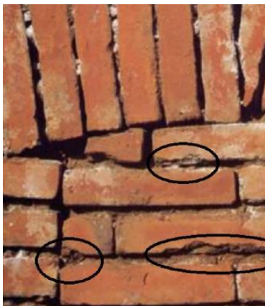
Figura 3.39 – Exemplo de esmagamento dos bordos de um tijolo de face à vista. (Resende, 2017)
