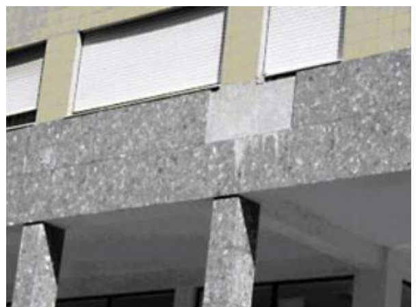
Figura 3.5 – Descolamento / queda das placas de pedra natural coladas em fachadas exteriores.
