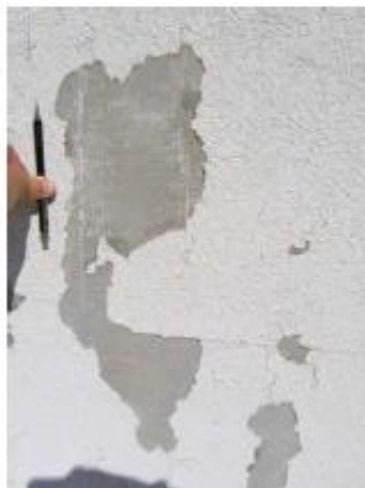
Figura 3.29 – Descasque do acabamento do sistema ETICS. (Lopes, 2005)
