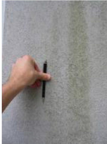
Figura 3.31 – Crescimento de uma alga no sistema ETICS. (Lopes, 2005)
