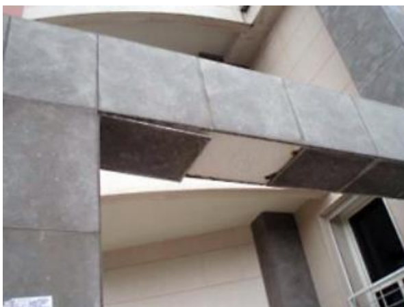
Figura 3.5 – Descolamento / queda das placas de pedra natural coladas em fachadas exteriores.
