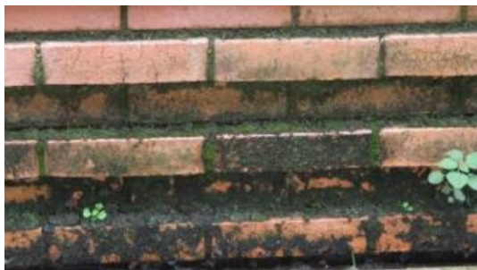
Figura 3.38 – Exemplo de presença de humidade ascensional e suas consequências na formação de musgo e líquenes. (Resende, 2017)
