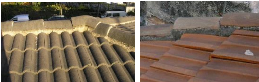
Figura 4.21 – Aplicação excessiva de argamassa na cumeeira e rincão e nos bordos laterais. (Brito, 2004; Garcez, 2009; Silva et al. , 1998)
