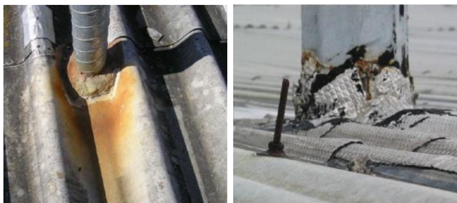
Figura 4.23 – Remate com tubagem executada em argamassa (à esquerda) e remate com tubagem executado com telas asfálticas (direita). (Garcez, 2009)
