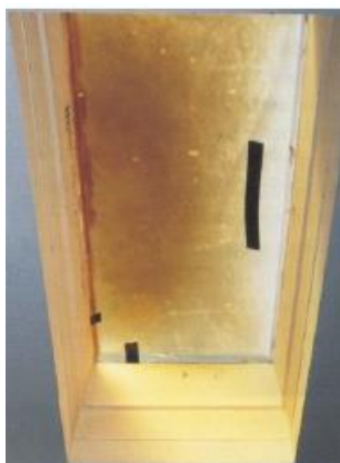
Figura 4.20 – Alteração de tonalidade por envelhecimento do revestimento em PVC. (Garcez, 2009)
