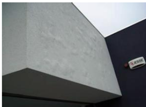
Figura 3.30 – Exemplo de empolamento do acabamento decorativo do sistema ETICS. (Lourenço, [s.d.]
