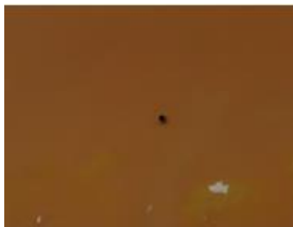
Figura 3.23 – Exemplo de descoloração de uma fachada por ação alcalina. (Lourenço, [s.d.]
