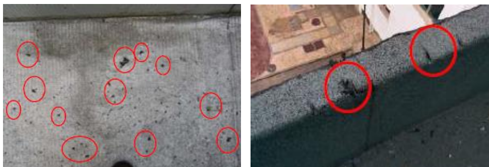
Figura 4.35 – Perfurações diversas de natureza estática (esquerda) e perfurações devido a ação mecânica, na platibanda (direita). (Araújo, Brito e Júlio, 2008; Conceição, 2015)
