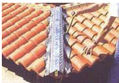
Figura 5.3 – Banda de ventilação em rincão. (Araújo, Brito e Júlio, 2008)
