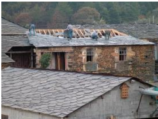
Figura 4.3 – Cobertura tradicional com soletos dispostos de forma irregular. (Garcez, 2009)
