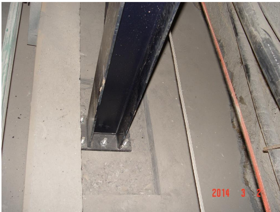
Ilustração 46 - Ligação Pilar/Viga da Ponte Rolante
