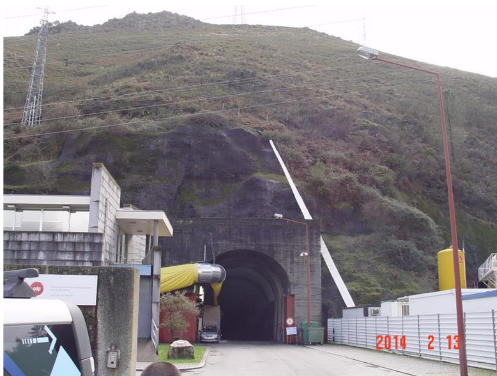
Ilustração 7 - Boca do Túnel de Acesso à Sala de Comando da Central VN II e VN III
