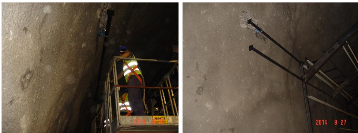
Ilustração 39 - Colocação de Escoras
