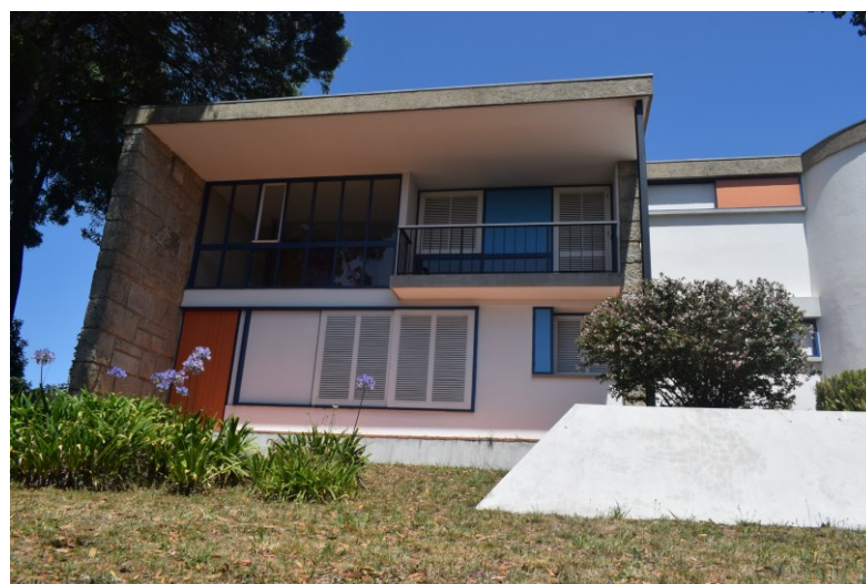
Figura 135- Vista exterior da Casa das Marinhas
