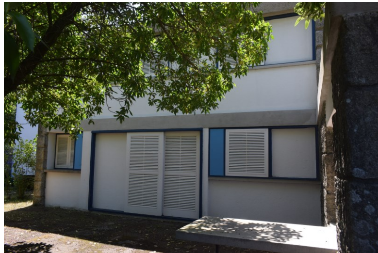
Figura 134- Vista exterior da Casa das Marinhas
