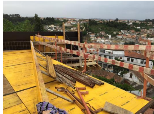
Figura 17 – Guarda-corpos na cobertura do edifício do spa .
