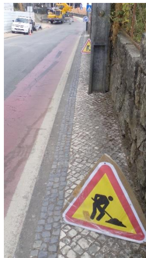
Figura 50 – Sinais de trânsito colocados na via pública.
