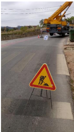
Figura 49 – Sinais de trânsito colocados perto de um cruzamento.
