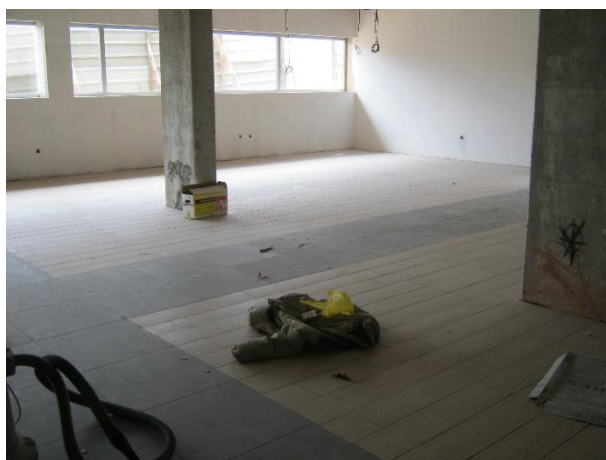
Figura 22 – Cerâmica colocado na sala de receção/estar do edifício principal do hotel.
