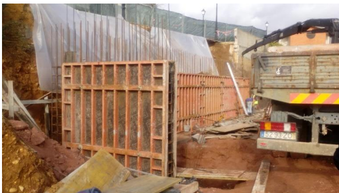
Figura 43 – Betonagem do muro de suporte.
