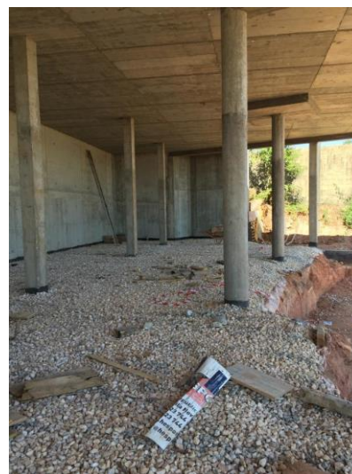
Figura 46 – Laje maciça da cobertura.
