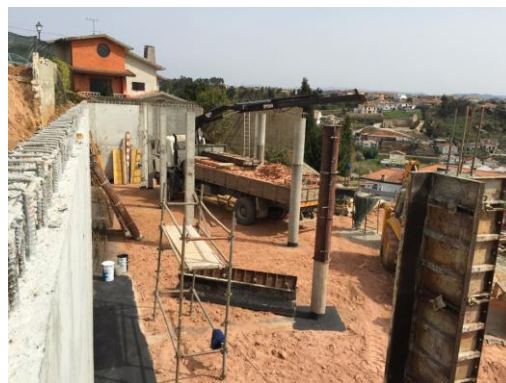
Figura 44 – Vista superior do muro de suporte e pilares.
