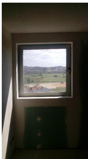
Figura 62 – Janela de um quarto do hotel.
