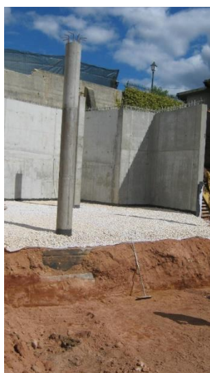
Figura 45 – Muro de suporte e pilares.
