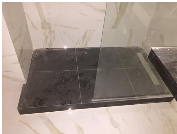
Figura 32 – Base de chuveiro de um quarto de banho de um quarto do edifício principal do hotel.
