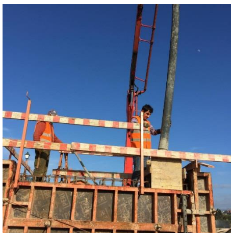
Figura 24 – Betonagem da parede resistente do edifício do spa .
