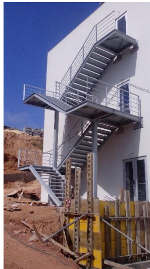
Figura 57 – Fachada oeste do hotel (idêntica à fachada este).
