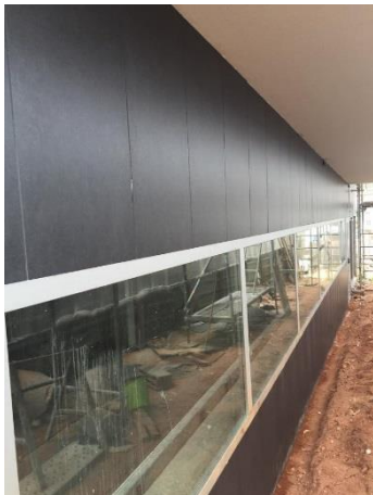
Figura 34 – Cerâmico de grés porcelânico aplicado na parede exterior da sala de receção do edifício principal do hotel.
