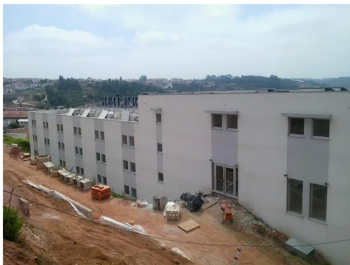
Figura 7 – Fachada norte do edifício principal do hotel.
