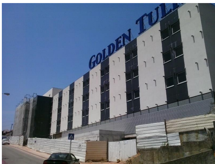
Figura 6 – Fachada sul do edifício principal do hotel.
