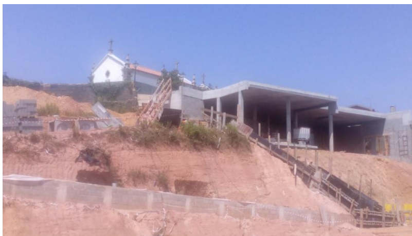
Figura 10 – Fachada sul do edifício anexo do spa .
