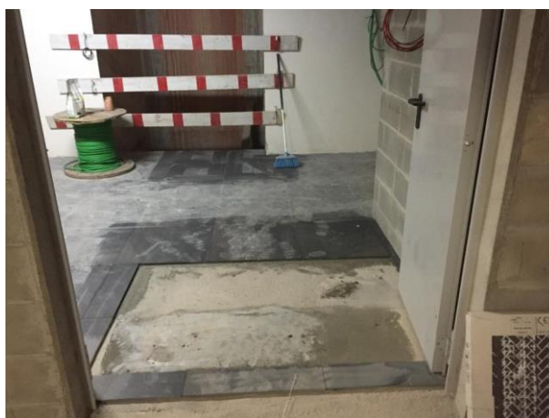
Figura 9 – Cerâmico colocado no hall do piso -1.
