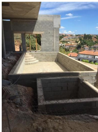
Figura 11 – Piscina do spa construída em alvenaria de bloco de cimento.
