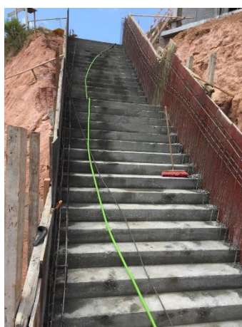
Figura 25 – Escadas executadas em betão armado de acesso entre o edifício principal do hotel e o edifício do spa .
