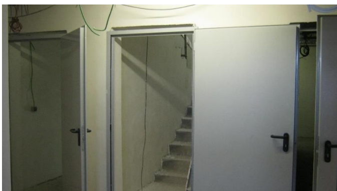
Figura 21 – Paredes do piso -1 rebocadas.
