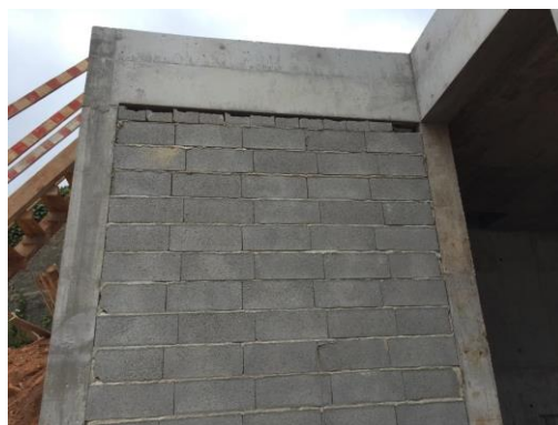
Figura 13 – Parede exterior do spa executada em alvenaria de bloco de cimento.
