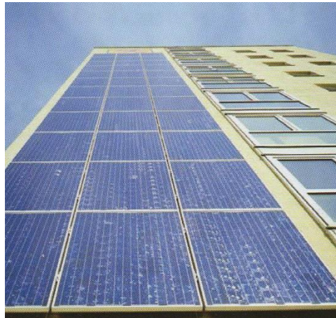
Figura 79 – BIPV instalado numa fachada.
