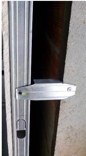
Figura 26 – Fixação da placa de gesso cartonado à parede de alvenaria de tijolo.
