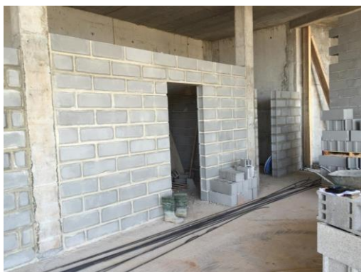
Figura 12 – Parede divisória interior do spa executada em alvenaria de bloco de cimento.
