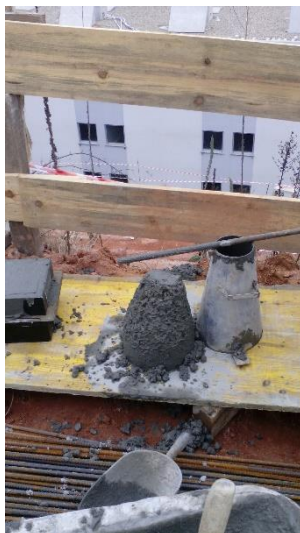
Figura 48 – Ensaio de abaixamento do betão executado em obra.
