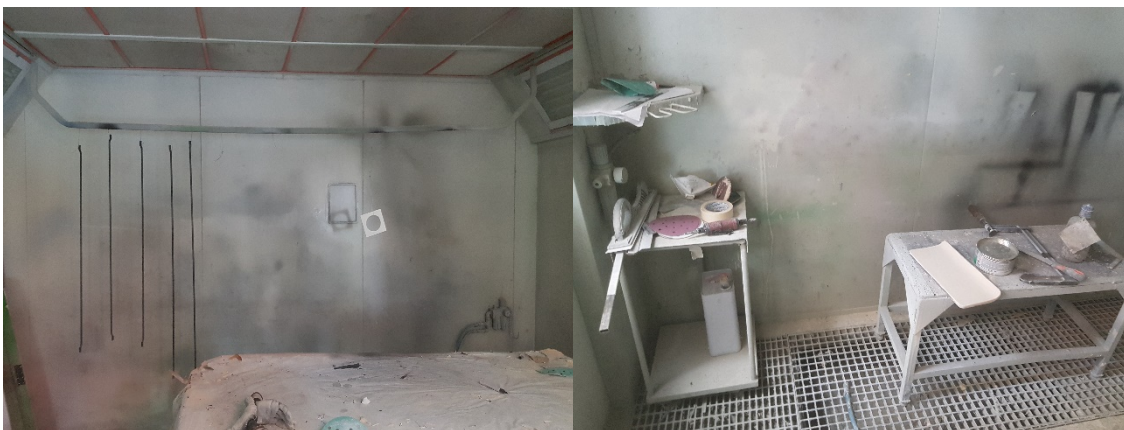
Figura 54 - Interior da Cabina
