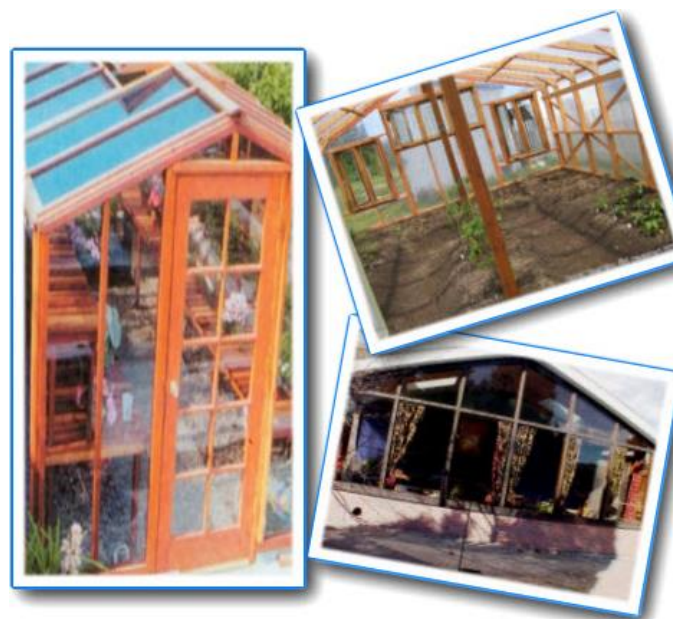
Figura 9 – Armação de suporte de madeira [10].
