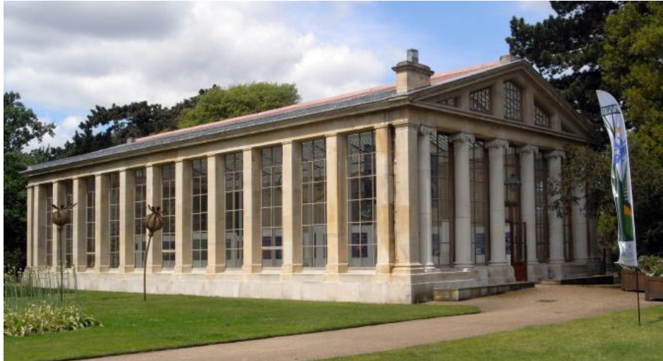
Figura 4 – A “Nash House” em Londres, Inglaterra, com origem em 1825, é uma das mais antigas estufas de vidro ainda existentes [6].
