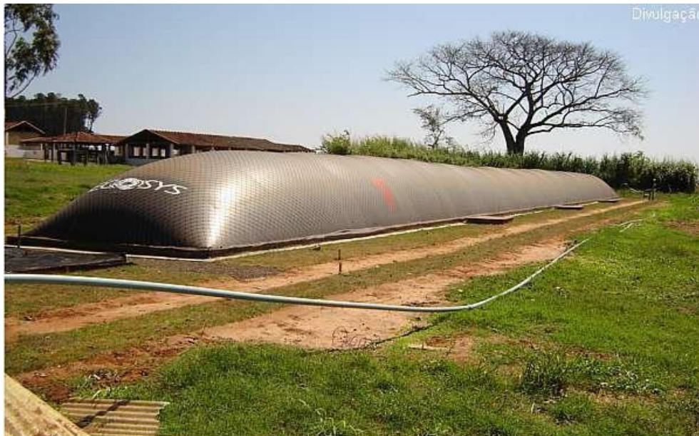
Figura 2.3 – Biodigestor em funcionamento
