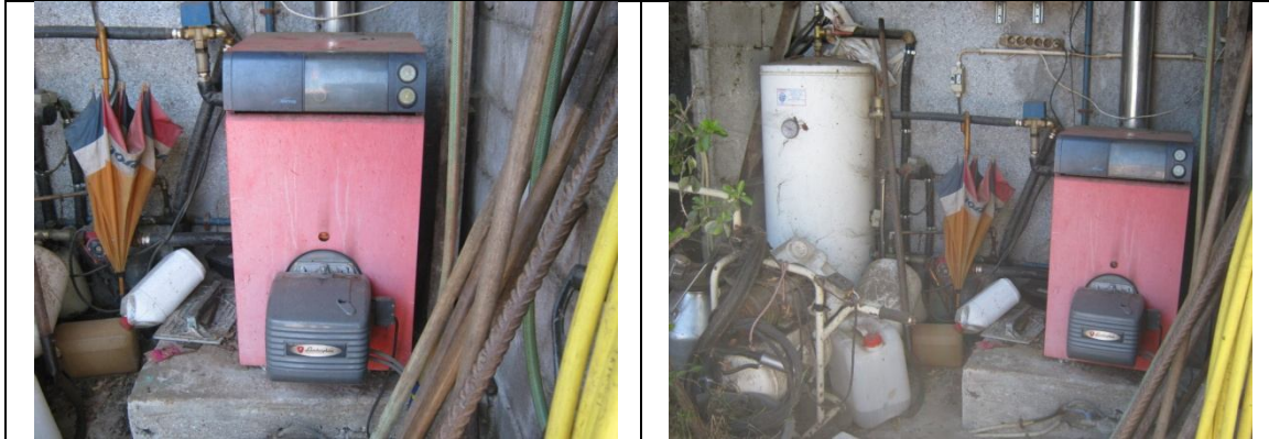
Figura 7.5 – Localização e estado de conservação da caldeira
