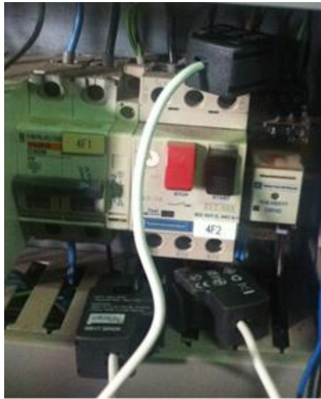
Figura 4.16 – Instalação de aparelhos de medida de energia.
