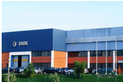
Figura 1.2 – Instalação da SKK®
