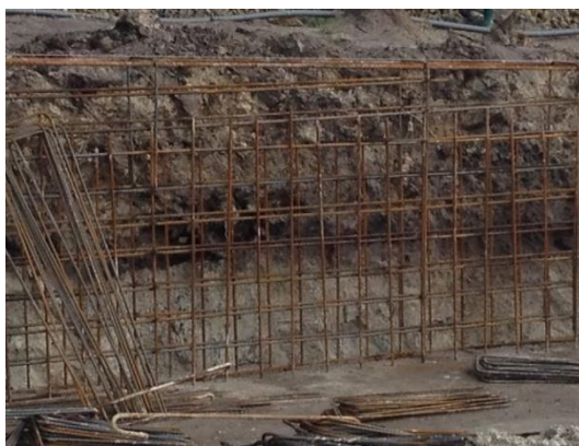
Fotografia 5.58 - Colocação de armadura do muro de contenção
