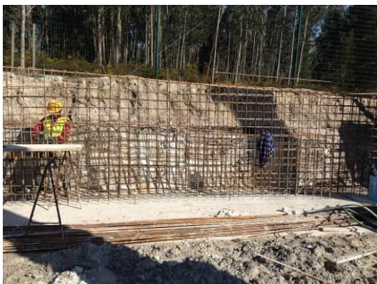
Fotografia 5.11 - Colocação da armadura no muro M4 (09-03-2015)
