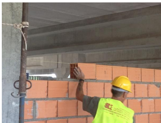
Fotografia 5.76 - Assentamento de tijolo
