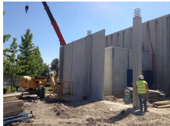
Fotografia 5.44 - Colocação de painéis em betão armado pré-fabricados do PT a ampliar (19-06-2015)
