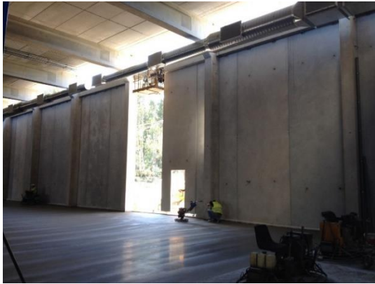
Fotografia 5.47 - Colocação de painéis em betão armado nervurados pré-fabricados (06-07-2015)
