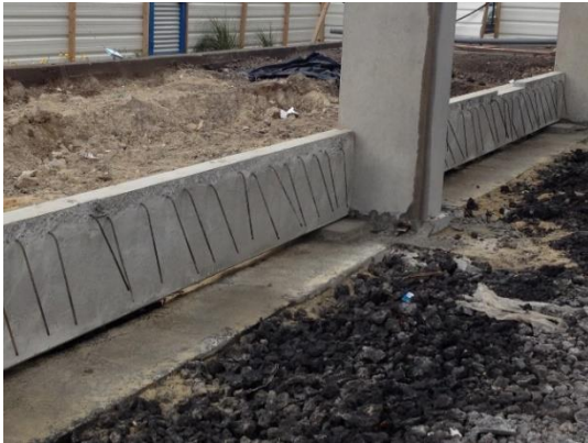
Fotografia 5.68 - Colocação de lintéis pré-fabricados
