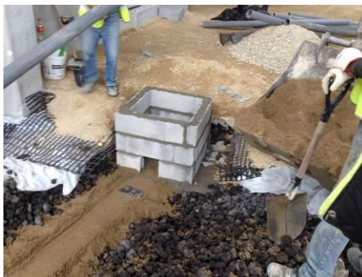
Fotografia 5.46 - Execução de câmara de visita da rede de drenagem de águas residuais no interior do edifício (30-06-2015)
