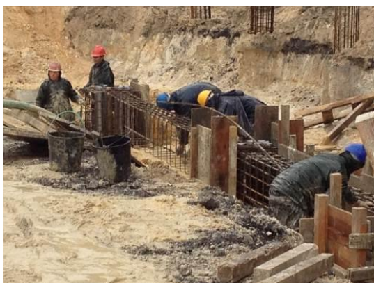
Fotografia 5.9 - Colocação de armaduras das vigas de fundação no alinhamento D (02-03-2015)
