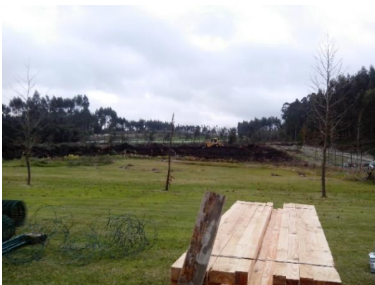
Fotografia 4.3 - Desmatação e decapagem de terra vegetal
