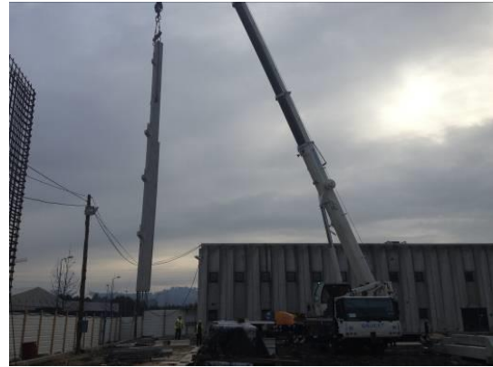
Fotografia 5.4 - Início de colocação dos pilares pré-fabricados (20-02-2015)
