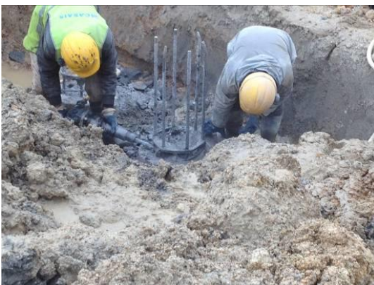
Fotografia 5.7 - Saneamento das cabeças das estacas (25-02-2015)
