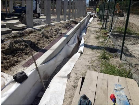
Fotografia 5.17 - Execução de dreno, incluindo fornecimento e aplicação de tubo geodreno, camada de brita envolta em geotêxtil ao longo do muro M4 (07-04-2015)
