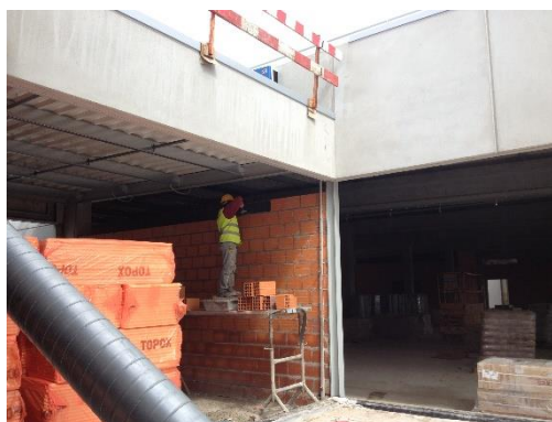
Fotografia 6.2 – Trabalhos de alvenaria em curso no piso 2
