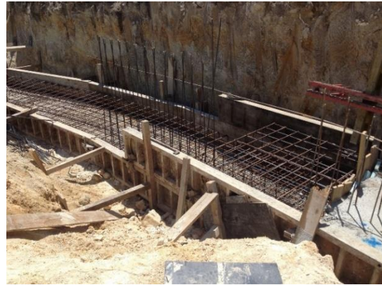
Fotografia 5.48 - Colocação de armadura do muro M3 (08-07-2015)
