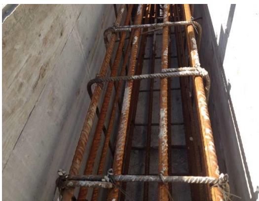
Fotografia 5.57 - Colocação de armadura de viga de fundação
