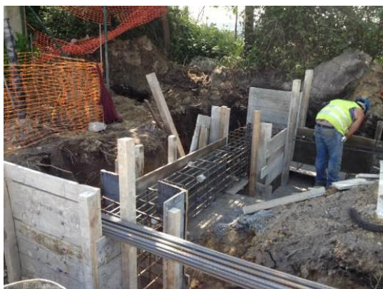
Fotografia 5.23 - Colocação da armadura das sapatas no edifício da portaria (21-04-2015)
