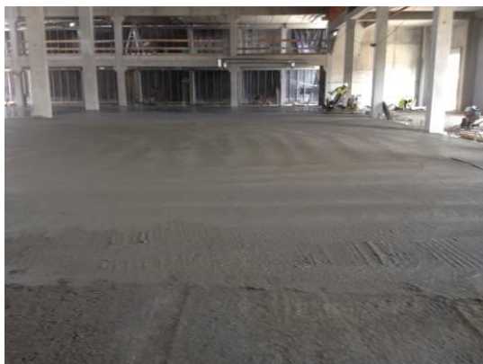
Fotografia 5.45 - Vista geral da pavimentação executada no piso 0 (30-06-2015)
