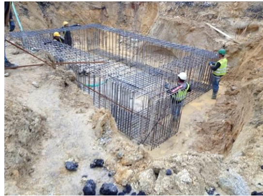
Fotografia 5.14 - Colocação das armaduras da sapata de fundação, no núcleo de escadas (12-03-2015)
