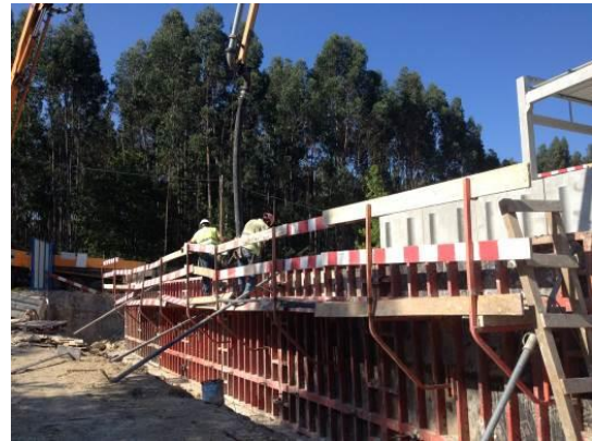
Fotografia 5.42 - Betonagem do muro M2 (16-06-2015)
