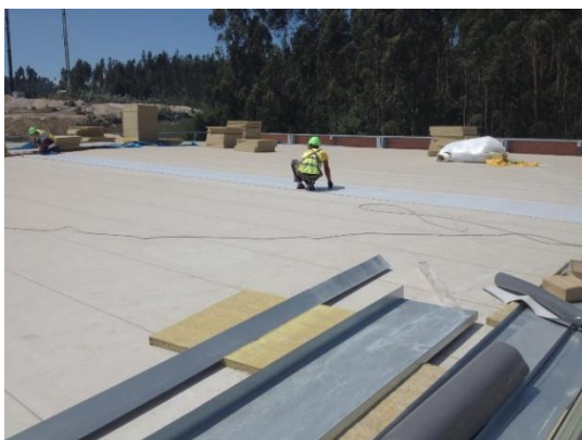
Fotografia 5.55 - Trabalhos de execução da cobertura (20-07-2015)
