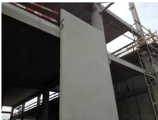
Fotografia 5.25 - Colocação de painéis em betão armado pré-fabricados (21-04-2015)
