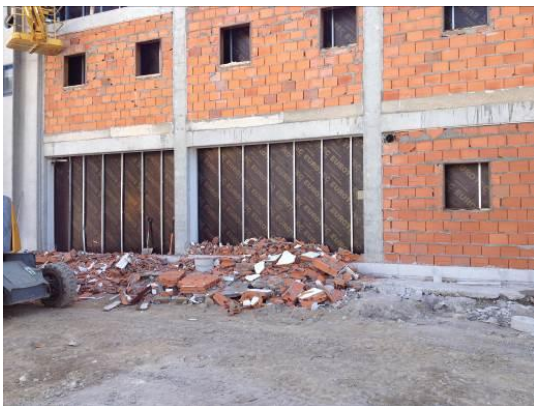
Fotografia 5.15 - Demolição de fachada do edifício existente (25-03-2015)
