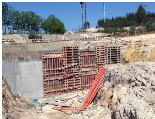
Fotografia 5.38 - Vista geral do reservatório – execução das paredes do reservatório: colocação de armadura, cofragem e betonagem (02-06-2015)
