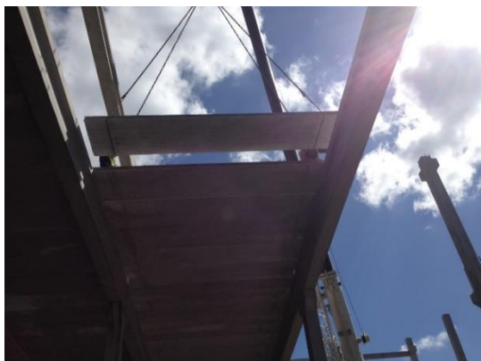
Fotografia 5.66 - Colocação de lajes aligeiradas alveolares pré-fabricadas
