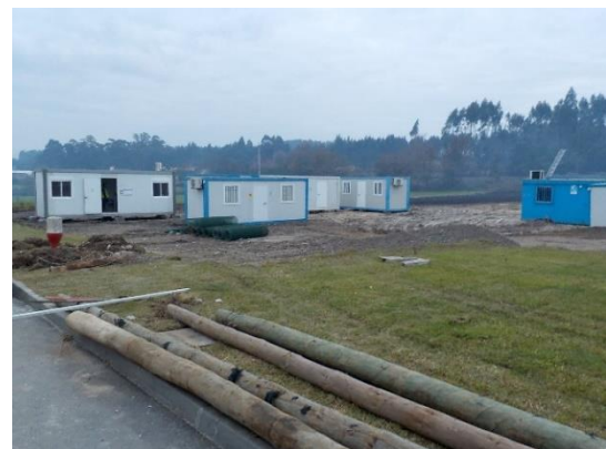
Fotografia 4.2 - Trabalhos de montagem de estaleiro
