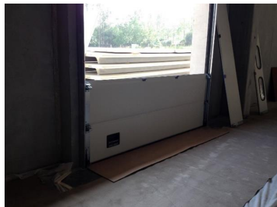
Fotografia 5.52 - Início dos trabalhos referentes à colocação de portões (15-07-2015)
