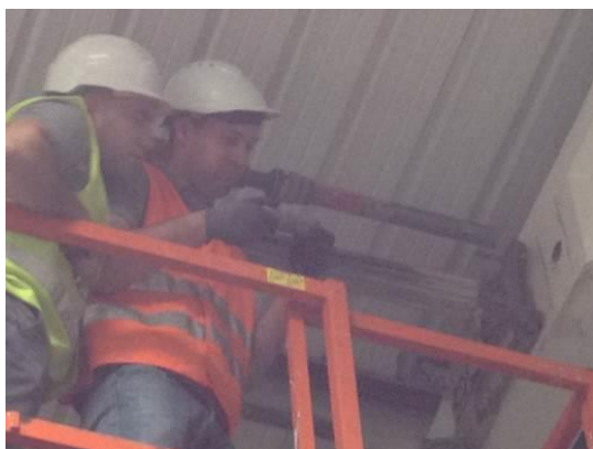
Fotografia 5.37 - Realização de ensaios às asnas do edifício existente (01-06-2015)
