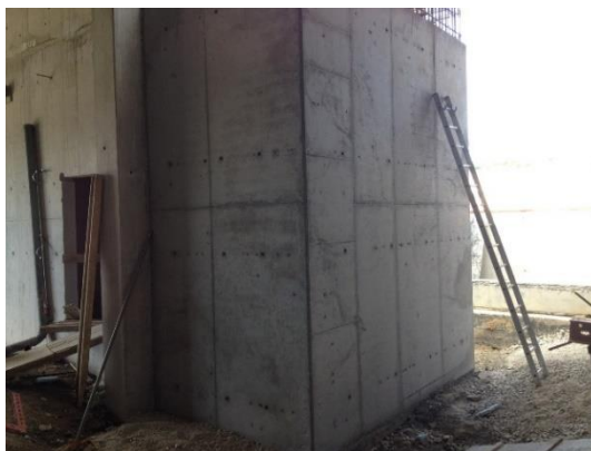
Fotografia 5.54 - Parede do monta-cargas betonada (20-07-2015)
