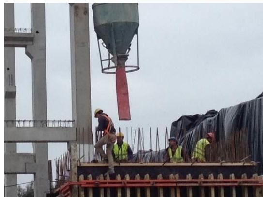
Fotografia 5.16 - Betonagem das paredes do núcleo de escadas LE4 (27-03-2015)
