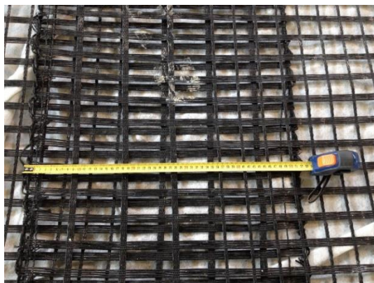
Fotografia 5.77 - Sobreposição de geogrelha em conformidade
