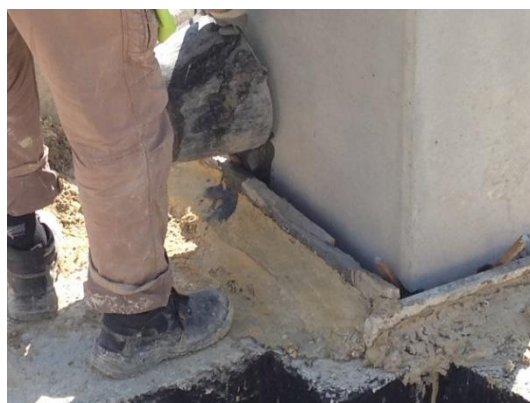
Fotografia 5.64 - Selagem da base dos pilares em betão armado pré-fabricados, com Sika Grout
