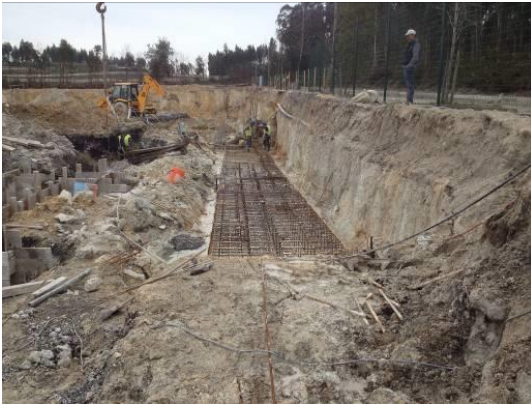
Fotografia 5.3 - Colocação de armadura para se proceder à betonagem da fundação do muro M4 (19-02-2015)
