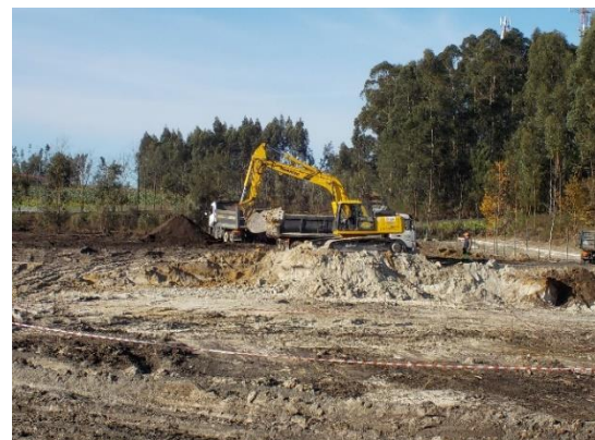
Fotografia 4.4 - Trabalhos de escavação em área de implantação do edifício de ampliação
