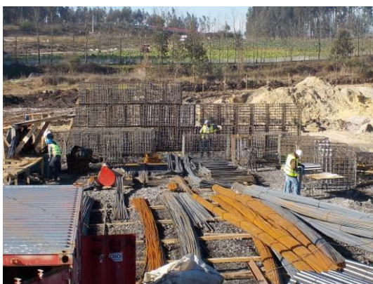
Fotografia 4.8 - Armação de maciços para encabeçamento de estacas
