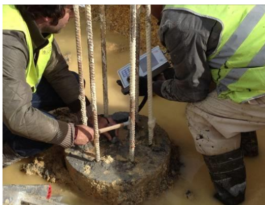
Fotografia 5.2 - Realização de ensaios sónicos para verificação da integridade das estacas (19-02-2015)
