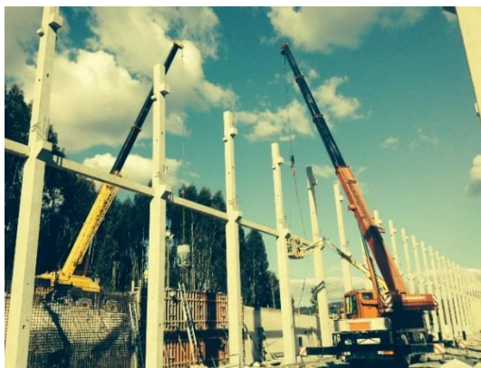
Fotografia 5.65 - Colocação de vigas pré-fabricadas
