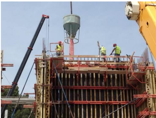
Fotografia 5.29 - Betonagem das paredes do núcleo de escadas LE3 (12-05-2015)
