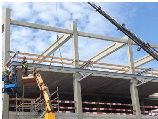
Fotografia 5.24 - Colocação de estrutura metálica das palas do edifício (21-04-2015)
