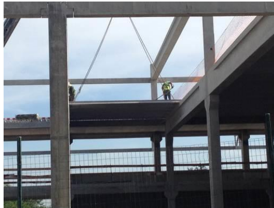
Fotografia 5.28 - Colocação de lajes pré-fabricadas em betão armado do piso 2 (11-05-2015)
