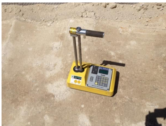
Fotografia 5.56 - Realização de ensaios de compactação do solo (23-07-2015)
