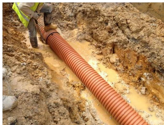
Fotografia 5.26 - Colocação de tubagem para se proceder à ligação entre câmaras de visita (29-04-2015)
