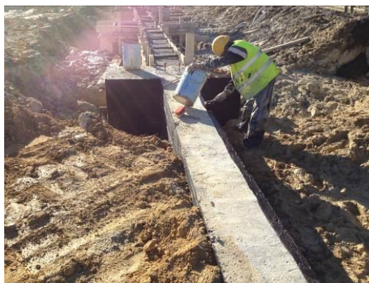
Fotografia 5.10 - Impermeabilização de elementos de fundação com emulsão betuminosa do tipo "Flintkote" (04-03-2015)
