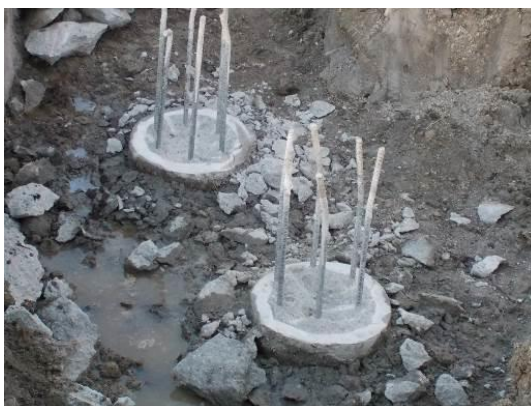
Fotografia 4.6 - Saneamento da parte superior das estacas
