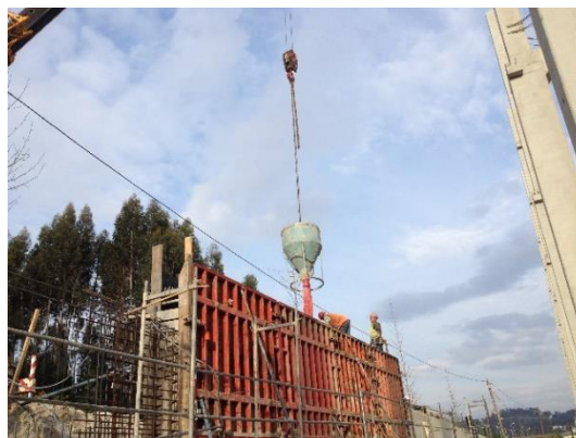
Fotografia 5.62 - Betonagem de muro de contenção
