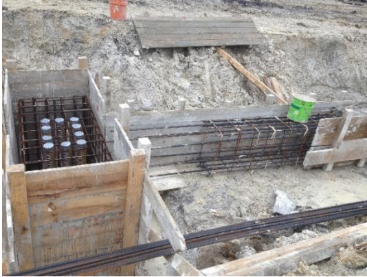
Fotografia 5.59 - Cofragem dos elementos construtivos: maciços e vigas de fundação
