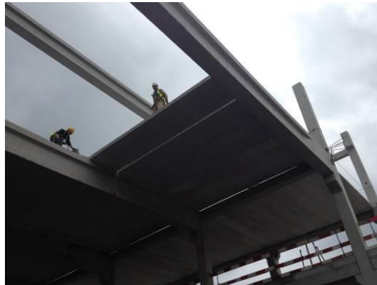
Fotografia 5.20 - Colocação de lajes pré-fabricadas em betão armado do 2º piso (14-04-2015)
