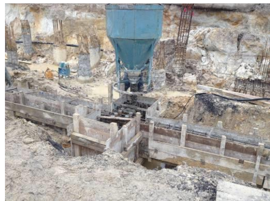
Fotografia 5.8 - Betonagem dos elementos construtivos no alinhamento D (26-02-2015)
