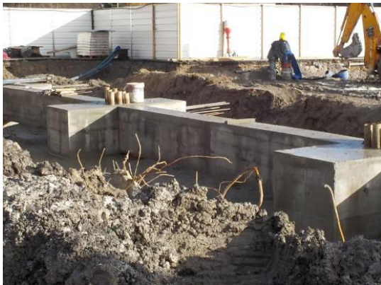
Fotografia 4.9 - Vigas de fundação contínuas e maciços de encabeçamento de estacas executados (02-02-2015)
