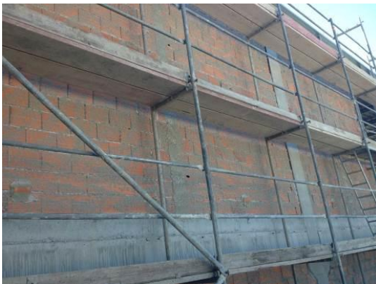
Fotografia 5.43 - Execução de parede exterior em alvenaria de tijolo (18-06-2015)
