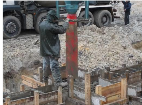
Fotografia 4.12 - Betonagem dos elementos construtivos no alinhamento D (13-02-2015)
