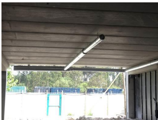
Fotografia 5.33 - Início dos trabalhos de AVAC (18-05-2015)
