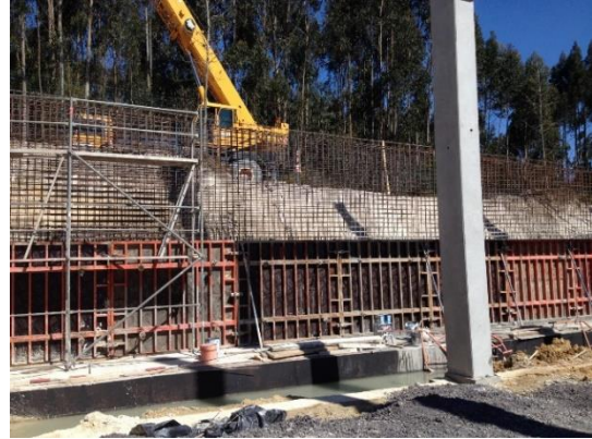
Fotografia 5.60 - Cofragem de muro de contenção
