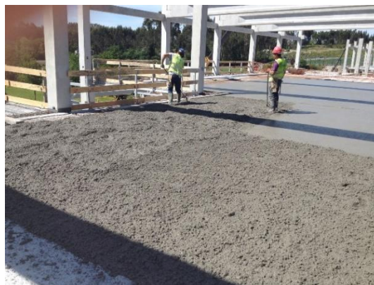
Fotografia 5.67 - Betonagem complementar das lajes aligeiradas alveolares pré-fabricadas
