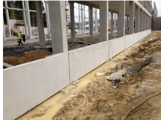
Fotografia 5.69 - Colocação de muretes pré-fabricados
