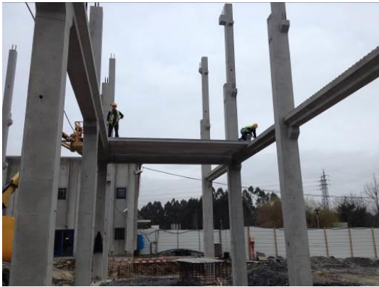
Fotografia 5.13 - Colocação das lajes LA16 (12-03-2015)
