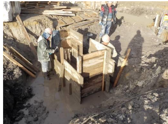
Fotografia 4.10 - Cofragem de um maciço de encabeçamento de estacas ME2.S (02-02-2015)
