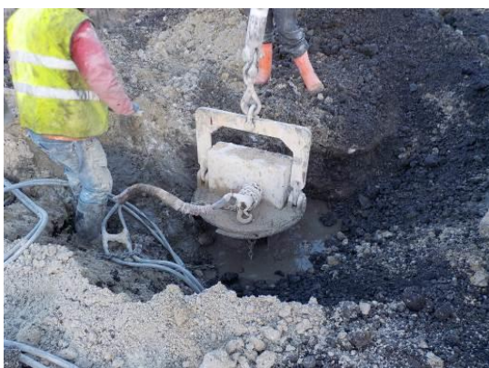
Fotografia 4.7 - Aplicação de armadura por vibração após betonagem da estaca
