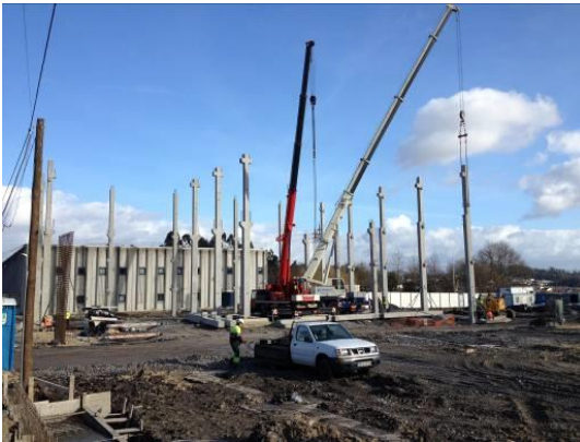
Fotografia 5.5 - Evolução dos trabalhos referentes à colocação dos pilares pré-fabricados (24-02-2015)
