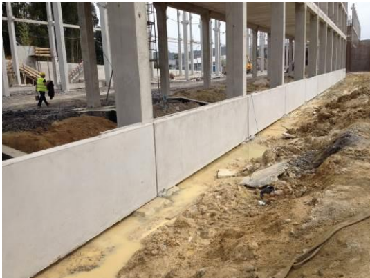
Fotografia 5.19 - Colocação de muretes em betão armado pré-fabricados (14-04-2015)
