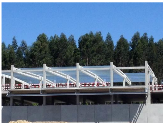
Fotografia 5.31 - Vista geral da estrutura metálica de cobertura (15-05-2015)
