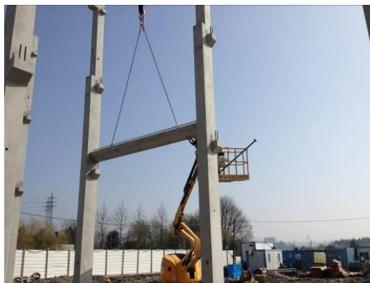
Fotografia 5.12 - Colocação das vigas pré-fabricadas (11-03-2015)
