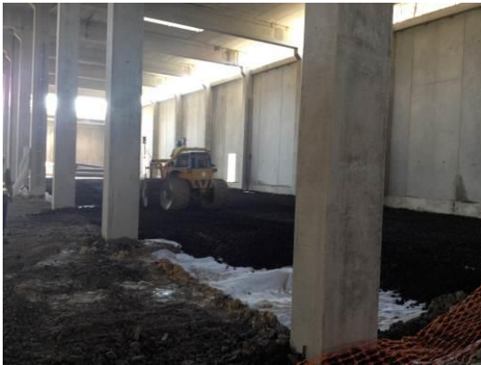
Fotografia 5.41 - Execução da base do pavimento (15-06-2015)
