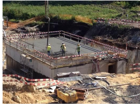
Fotografia 5.40 - Betonagem da laje de cobertura do reservatório (15-06-2015)
