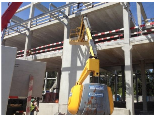
Fotografia 5.70 - Colocação de painéis lisos pré-fabricados
