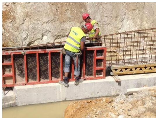
Fotografia 5.32 - Montagem da cofragem do muro M1 (18-05-2015)
