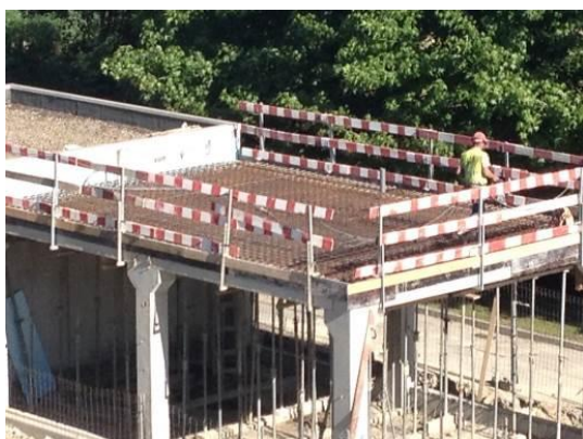
Fotografia 5.35 - Colocação de armadura na cobertura do edifício de resíduos sólidos a ampliar (27-05-2015)
