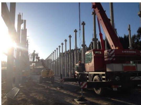
Fotografia 5.63 - Colocação de pilares em betão armado pré-fabricados
