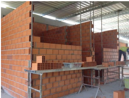
Fotografia 5.49 - Execução de paredes interiores de alvenaria em tijolo (09-07-2015)
