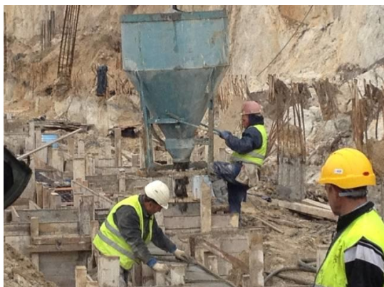
Fotografia 5.61 - Betonagem de maciços e vigas de fundação
