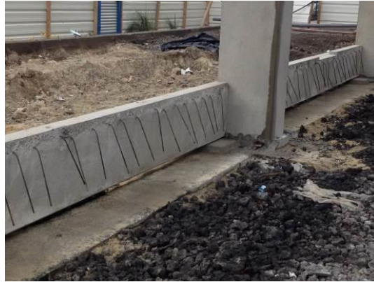
Fotografia 5.18 - Colocação de lintéis em betão armado pré-fabricados (10-04-2015)
