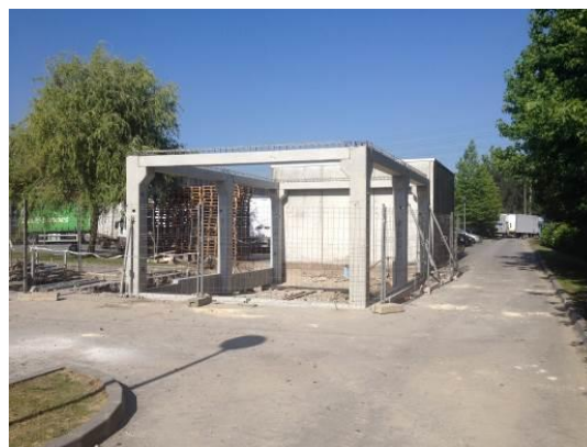
Fotografia 5.34 - Vista geral do edifício da zona dos resíduos sólidos – pilares, vigas e lintéis em betão armado pré-fabricados colocados (22-05-2015)
