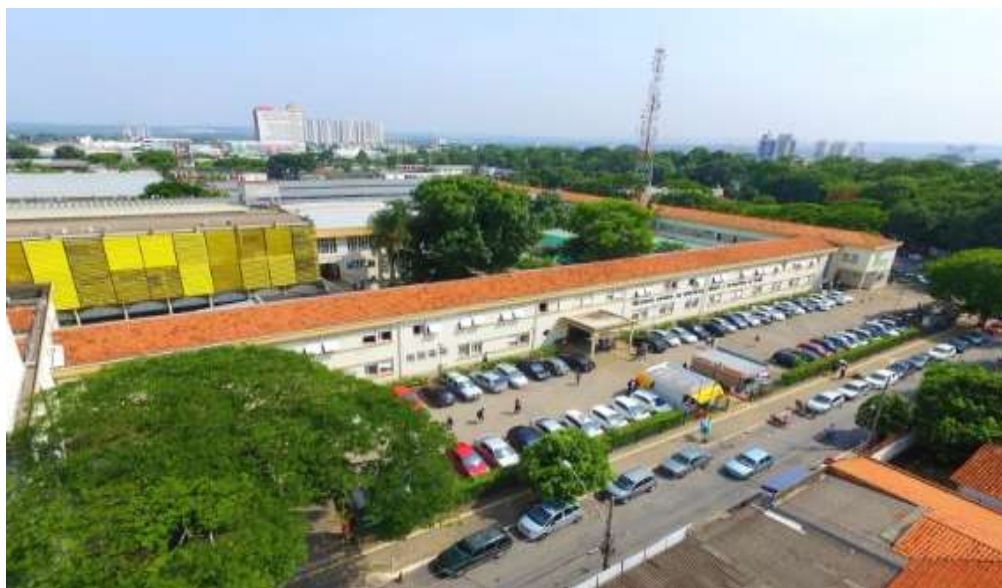
Figura 5 – Fachada atual do IFG Fonte: Site do IFG.
