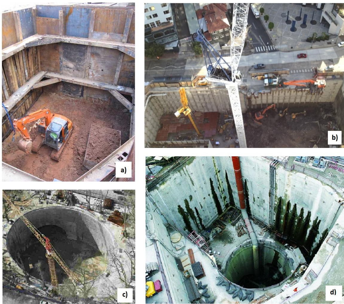
Figura 2.1 – Geometria dos poços: a) Quadrada; b) Retangular; c) Circular/elíptica; d) Mista.
