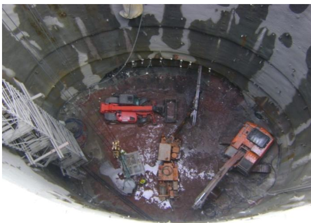
Figura 6.52 – a) Tratamento do emboquilhamento do túnel de ventilação; b) Cortina de enfilagens e pregagens do túnel de ventilação.
