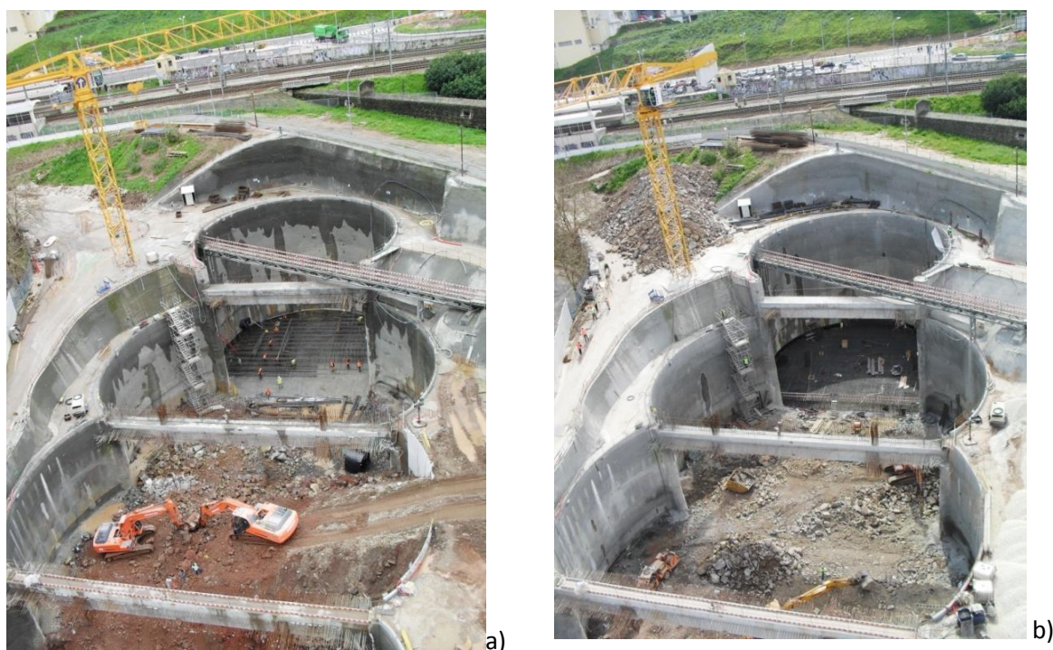
Figura 6.38 - Plano geral dos poços 3 a 5. a) Com pormenor da rampa utilizada pelo dumper; b) sem rampa, utilizando caçamba para remoção do material.
