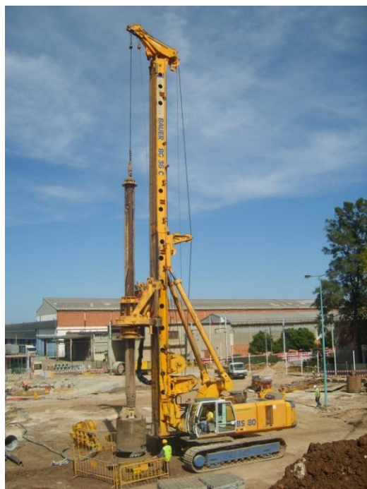
Figura 6.35 – a) furação para as estacas pilares; b) Colocação de armadura na estaca pilar no furo.
