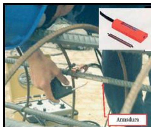
Extensómetros do tipo "strain-gauge".
