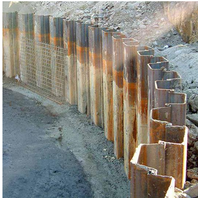
Figura 2.11 - Cortina de estaca prancha (site: engenhariacivil.com).
