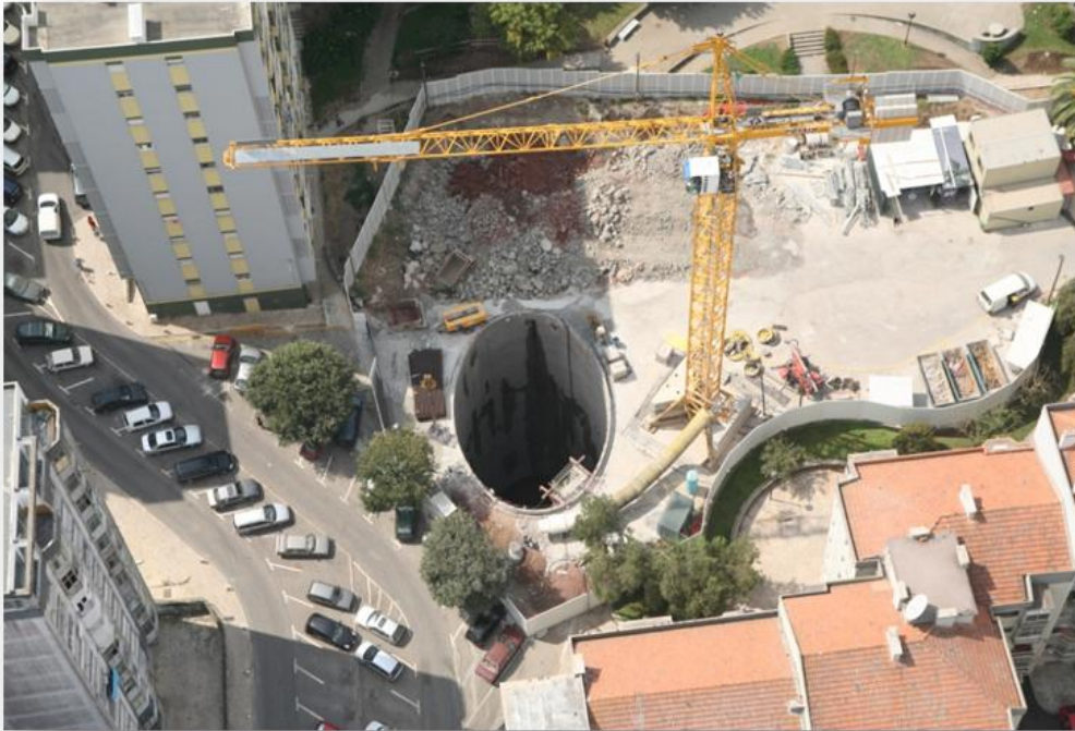
Figura 6.55 - Vista aérea do poço de ventilação.
