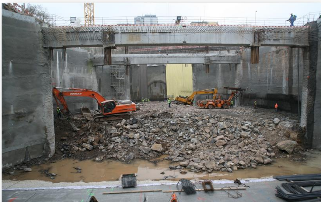
Figura 6.47 - Vista geral do interior do poço da estação próximo da cota de projeto.
