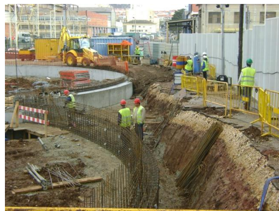
Figura 6.36 – a) Montagem da armadura das vigas de travamento entre estacas pilar; b) Vigas de bordadura no topo de cada poço.
