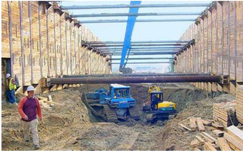
Figura 2.6 - Cortina de contenção tipo Berlim provisório com escoramento (site: engenhariacivil.com).
