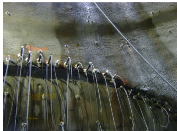
Figura 6.52 – a) Tratamento do emboquilhamento do túnel de ventilação; b) Cortina de enfilagens e pregagens do túnel de ventilação.
