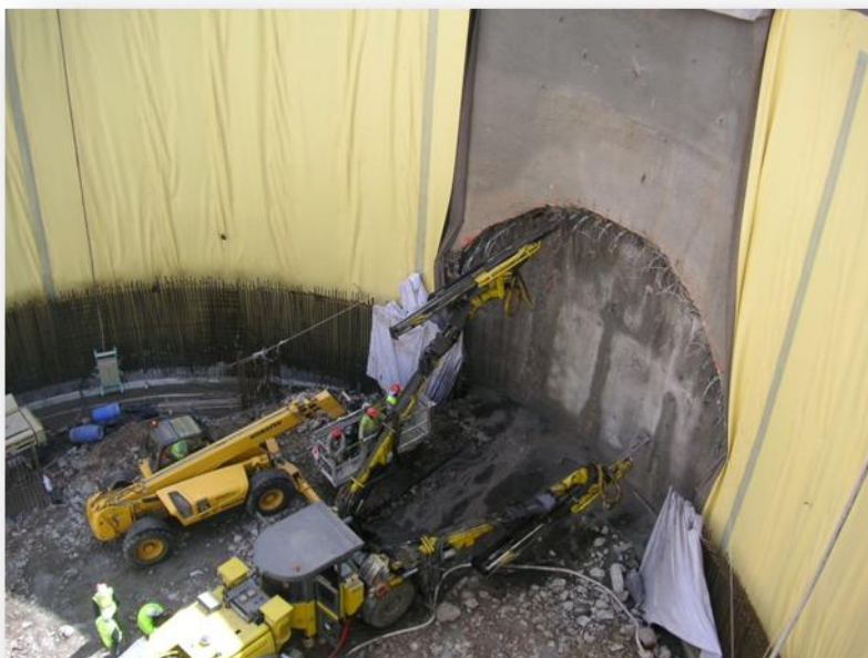
Figura 6.46 - Tratamento do emboquilhamento do túnel sul, com equipamento de perfuração de 2 braços.
