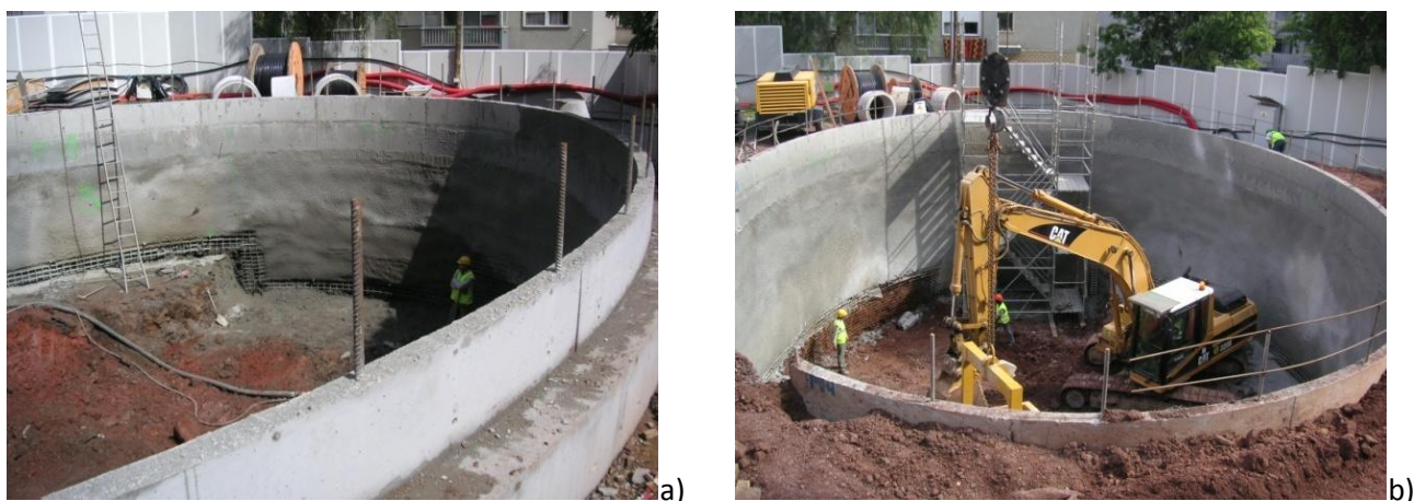
Figura 6.49 – a) Viga de bordadura do poço de ventilação; b) Execução de escavação por meios mecânicos.
