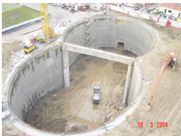
Estação de Salgueiros – Metro do Porto.
