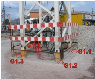
Gráfico 7.9 - Evolução das deformações das marcas de superfície da Grua 1 (EPOS, 2010).
