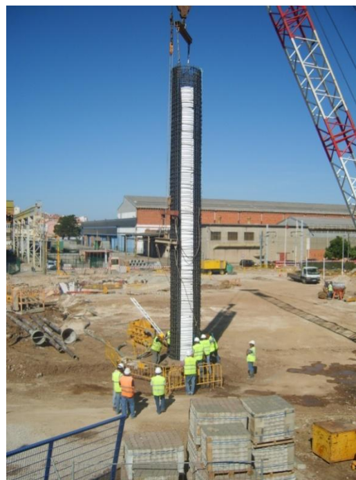
Figura 6.35 – a) furação para as estacas pilares; b) Colocação de armadura na estaca pilar no furo.
