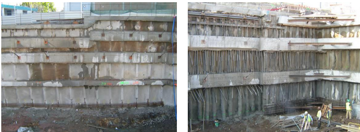
Figura 2.9 - Cortina de estacas com ancoragens nas vigas, executada na obra em estudo (NE ACE, 2011).
