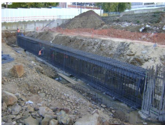
Figura 6.36 – a) Montagem da armadura das vigas de travamento entre estacas pilar; b) Vigas de bordadura no topo de cada poço.
