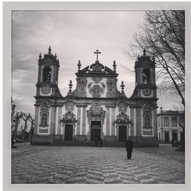
Figura 8 – Fotografia tirada à igreja de Matosinhos para a geocache.
