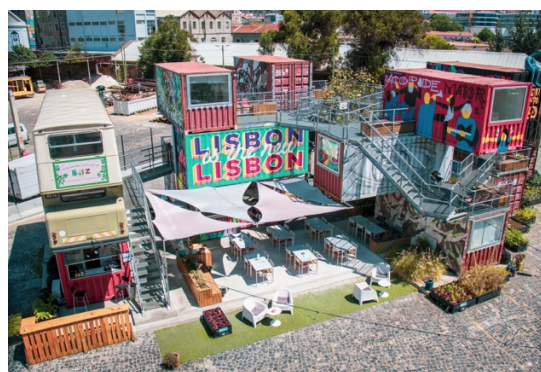
Figura 29 - Estrutura Exterior do Village Underground Lisboa.
