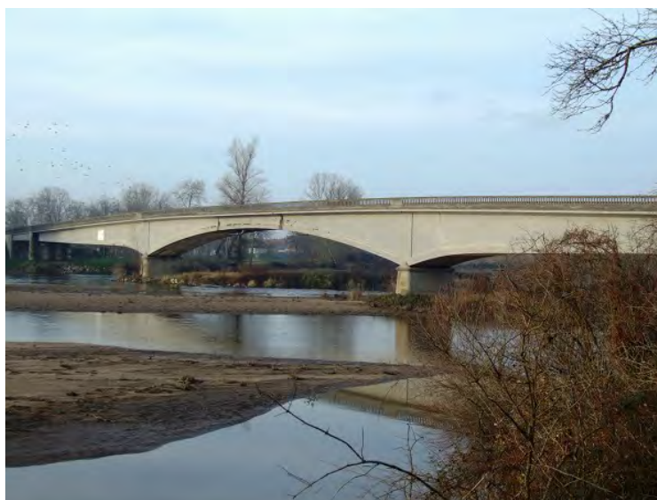
Figura 29 – Ponte La Veudre, França
