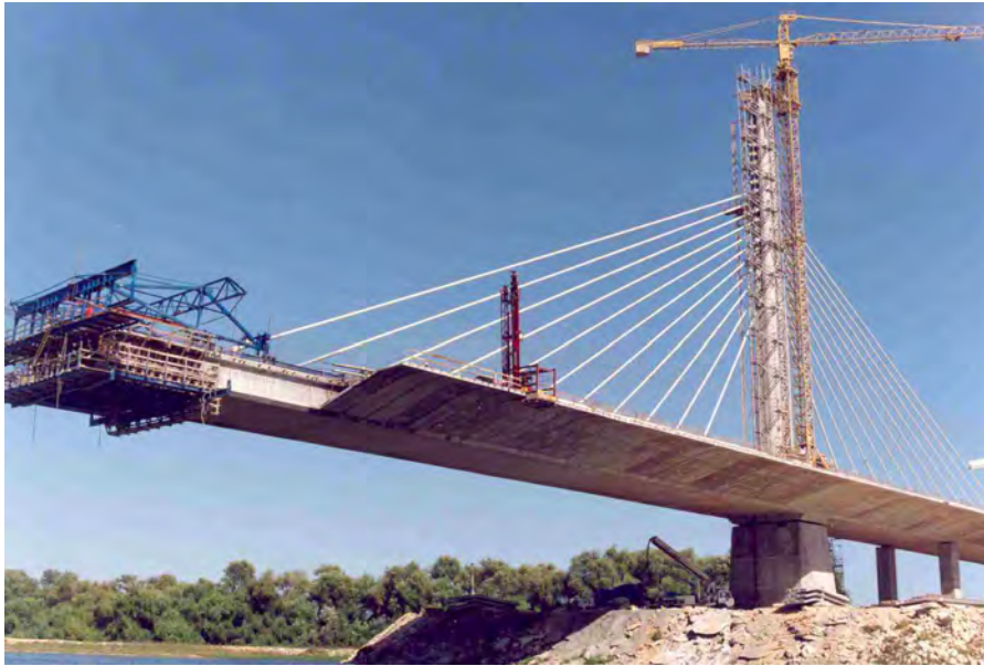
Figura 112 – Construção da ponte Salgueiro Maia, Santarém
