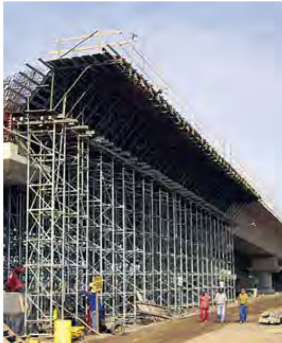
Figura 74 – Solução de cimbra ao solo
