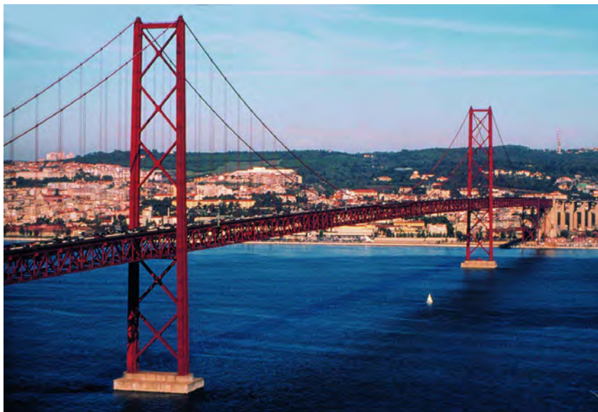
Figura 122 – Ponte 25 de Abril, Lisboa
