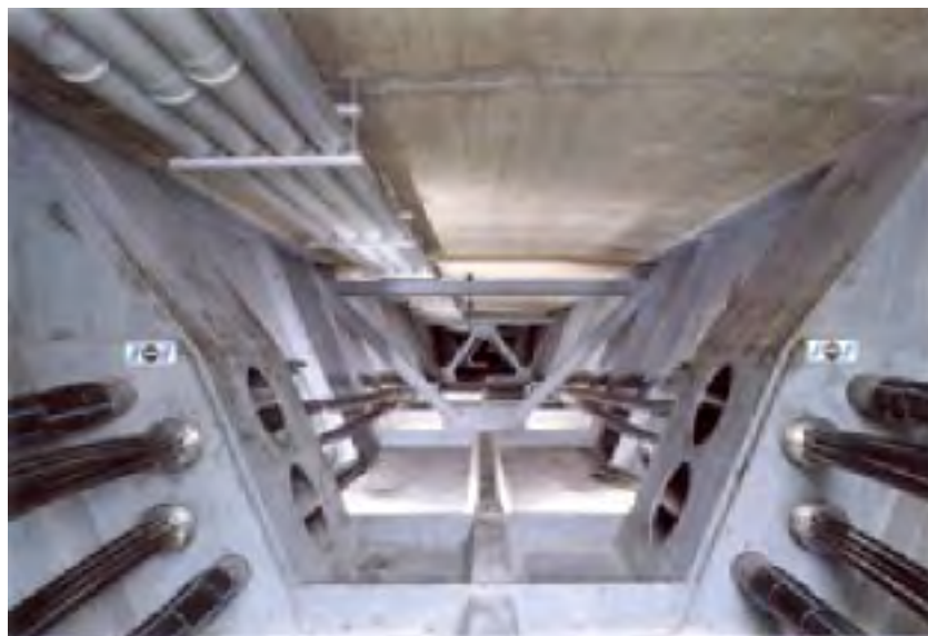
Figura 63 - Pré-esforço exterior
