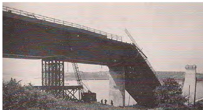
Figura 130 – Colapso da Ponte Cleddau
