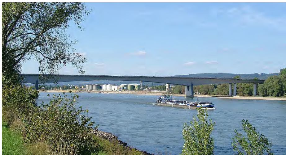
Figura 32 – Ponte Bendorf, Alemanha
