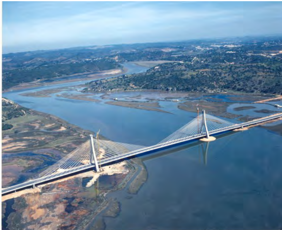
Figura 89 – Ponte sobre o Rio Arade, Portimão
