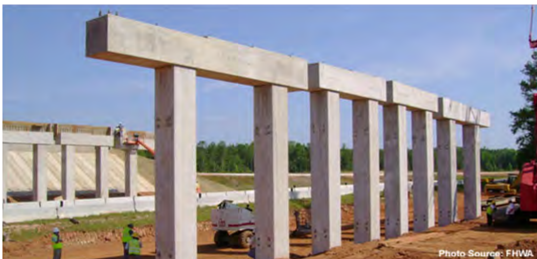
Figura 41 – Pilares de vigas de uma ponte pré-fabricados
