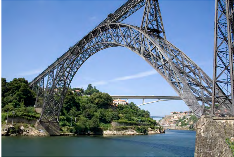
Figura 14 – Ponte Maria Pia no Porto, Portugal
