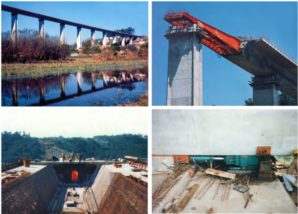
Figura 101 - Construção da ponte sobre o rio Águeda
