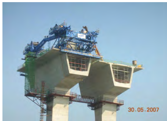
Figura 90 – Avanços Sucessivos em viga
