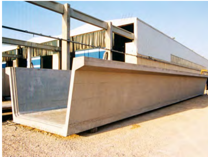
Figura 40 – Viga em caixão
