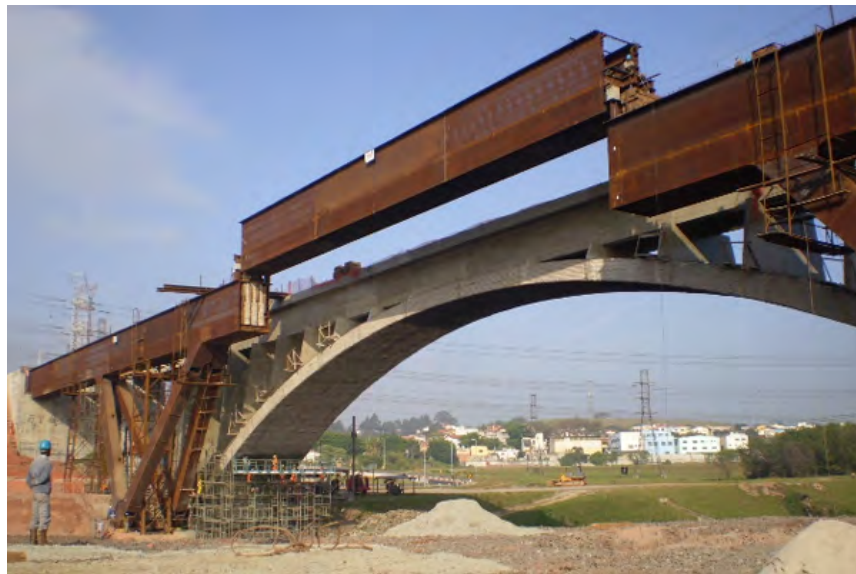
Figura 128 – Viga metálica em caixão
