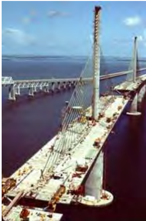
Figura 55 - Ponte Sunshine Skyway em construção, EUA
