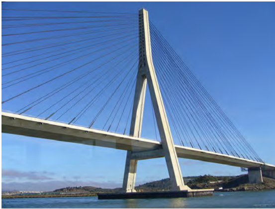
Figura 116 – Ponte do Guadiana
