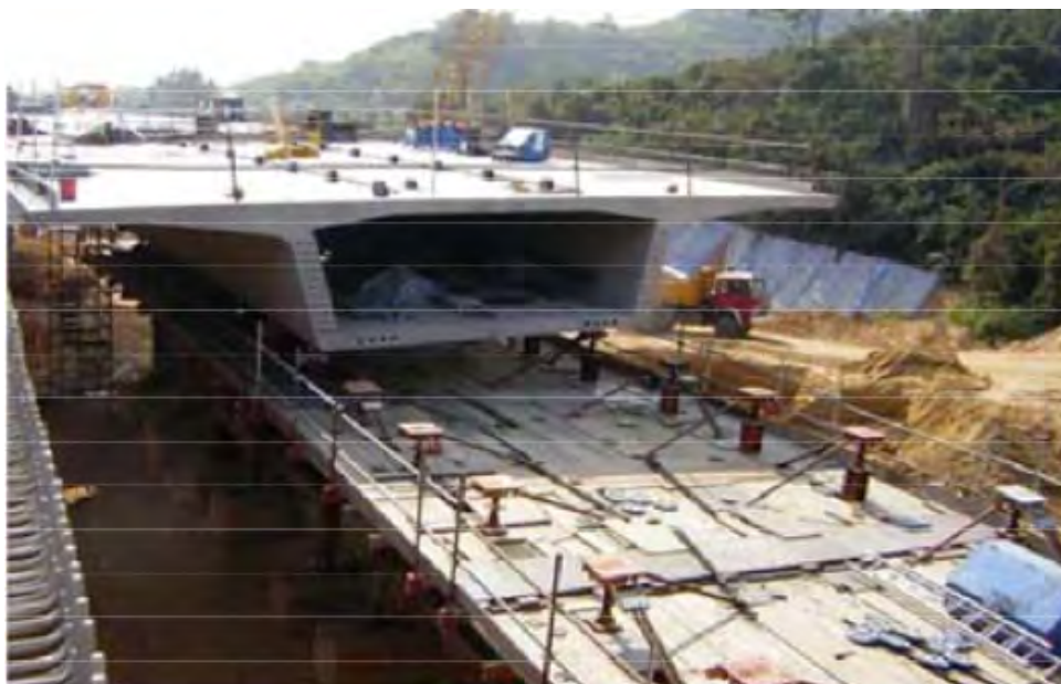
Figura 50 – Colocação das aduelas pré-fabricadas sobre o cimbra
