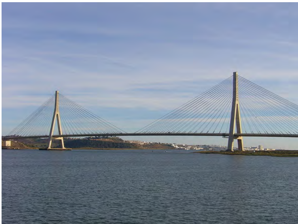
Figura 88 – Ponte sobre o rio Guadiana, Castro Marim
