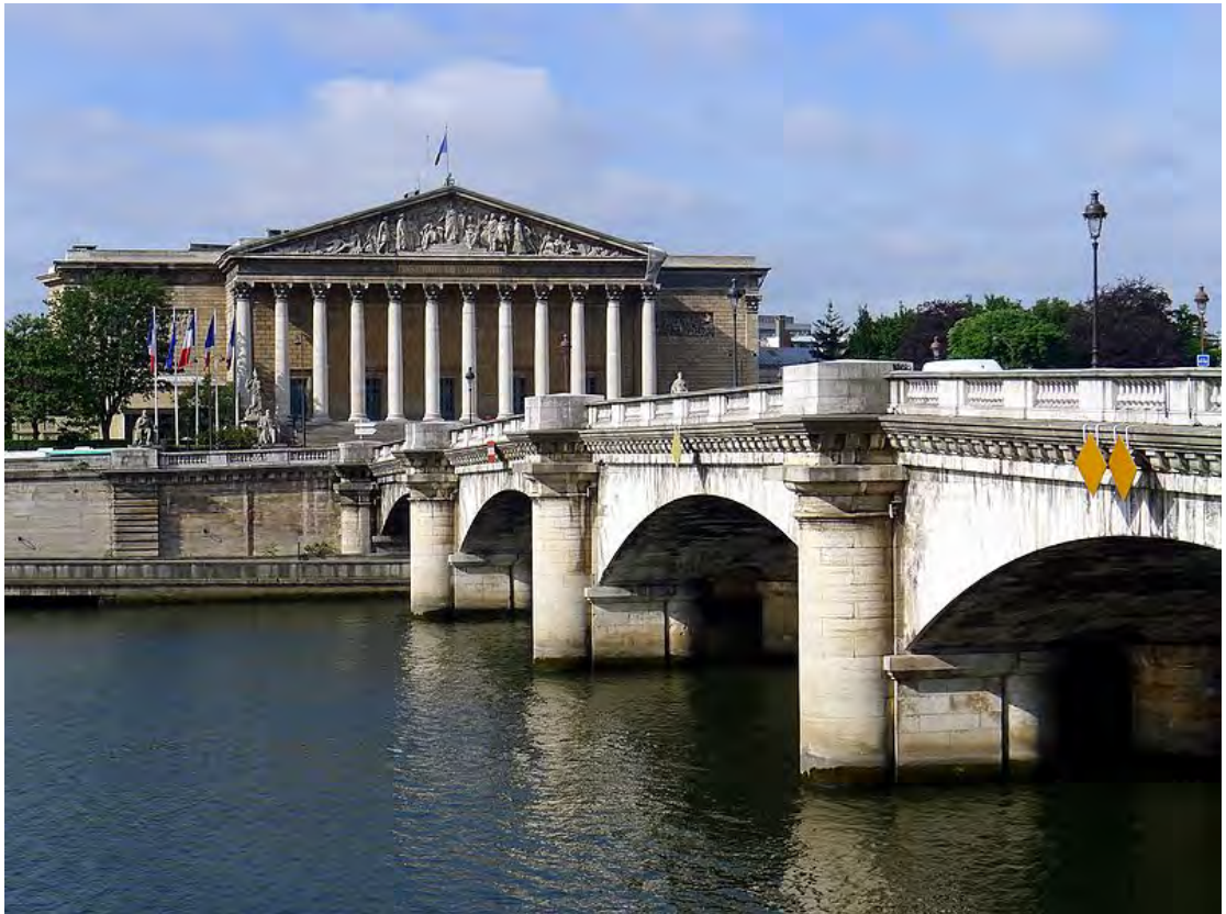
Figura 6 - Ponte de la Concorde em Paris, França
