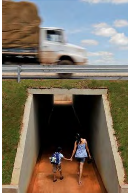
Figura 66 – Passagem inferior de peões
