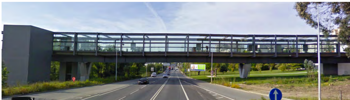
Figura 84 – Estação do Metro – Parque da Maia
