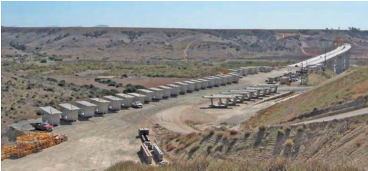
Figura 58 - Estaleiro de aduelas pré-fabricadas
