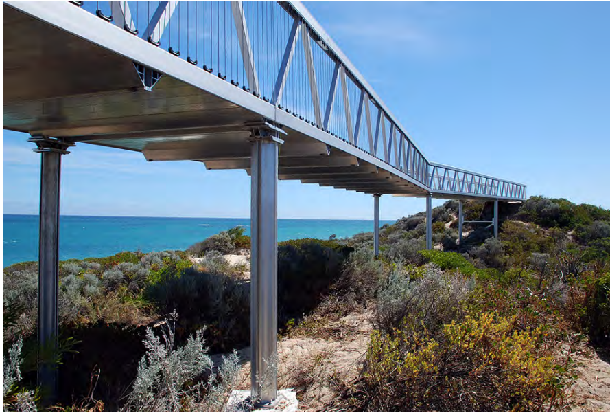
Figura 36 – Passagem em alumínio
