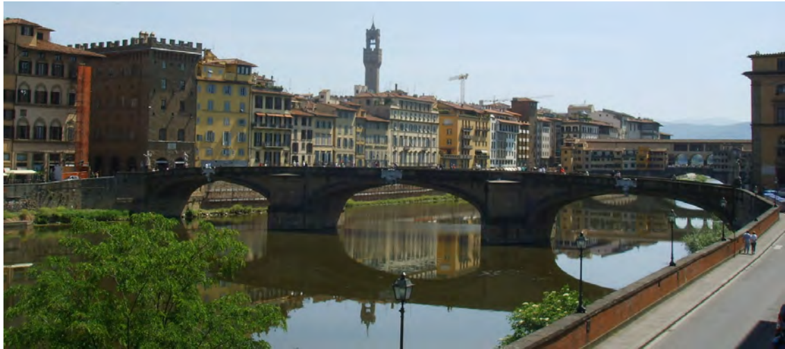
Figura 4 – Ponte Santa Trinitá em Florença, Itália
