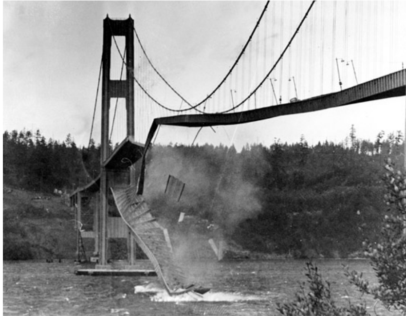
Figura 151 – Colapso da ponte Tacoma
