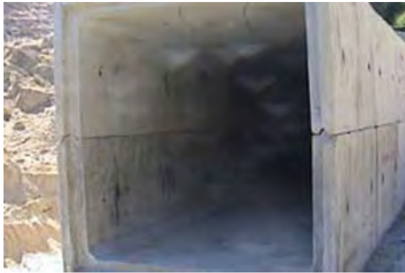
Figura 69 – Duas peças em U, Box Culvert
