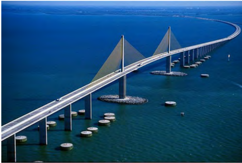
Figura 56 - Ponte Sunshine Skyway, EUA
