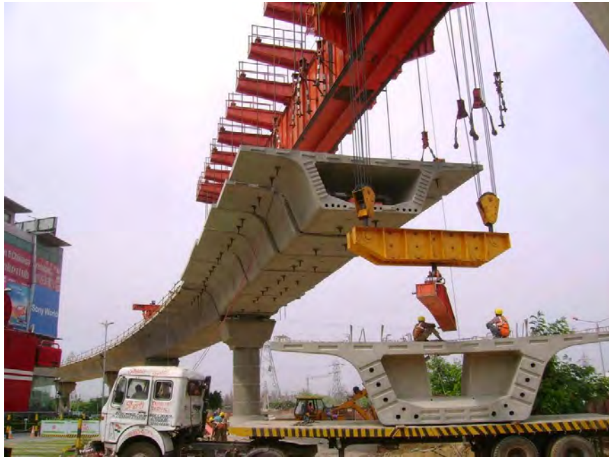
Figura 49 – Guindaste para colocação das aduelas pré-fabricadas
