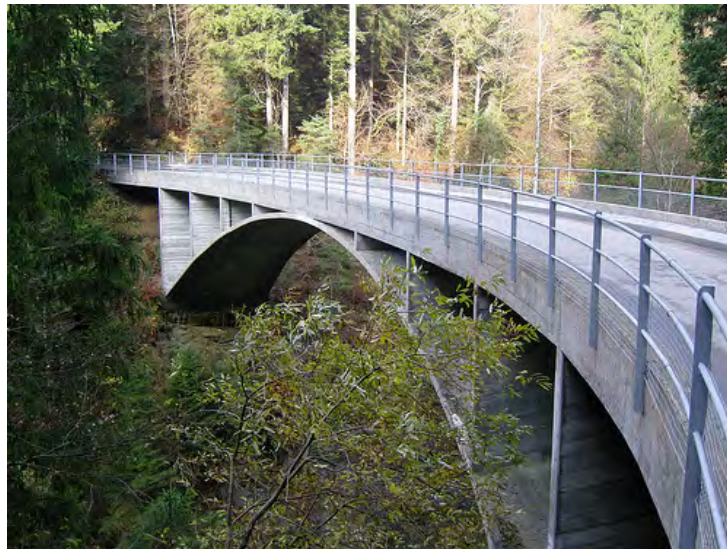
Figura 28 – Ponte Schwandbach, Suíça
