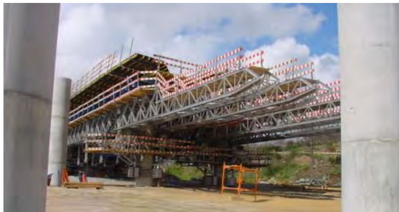
Figura 104 – Viga de lançamento inferior
