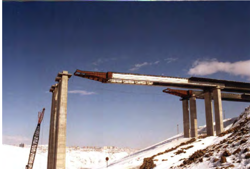
Figura 95 – Sistema de lançamento incremental
