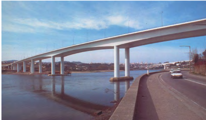
Figura 87 – Ponte do Freixo, Porto
