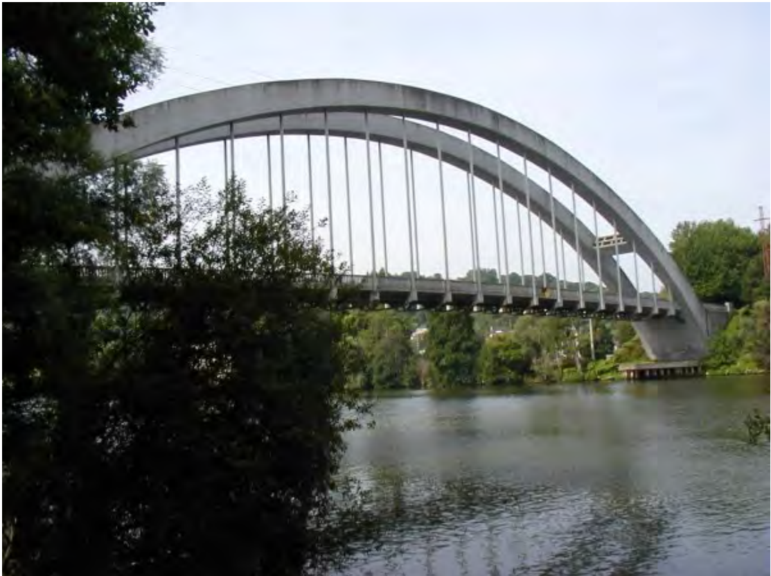
Figura 24 – Ponte Vauvray, França
