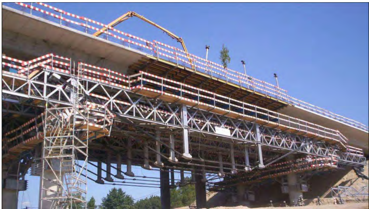
Figura 107 – Exemplo de estrutura construída com sistema OPS
