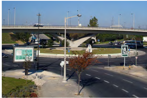
Figura 45 – Vista do Viaduto da Praça do Relógio
