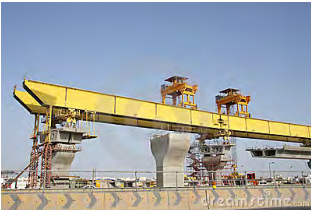
Figura 105 – Viga de lançamento de assemblagem
