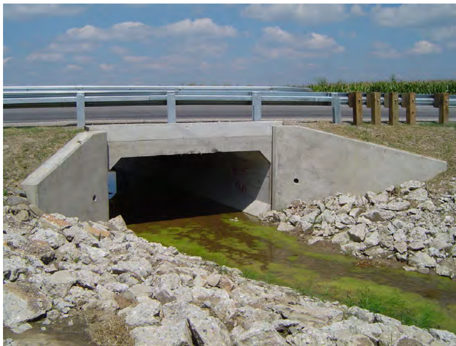
Figura 70 – Aplicação do Box-Culvert
