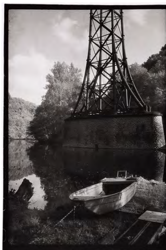
Figura 13 – Apoios do viaduto de Rouzat
