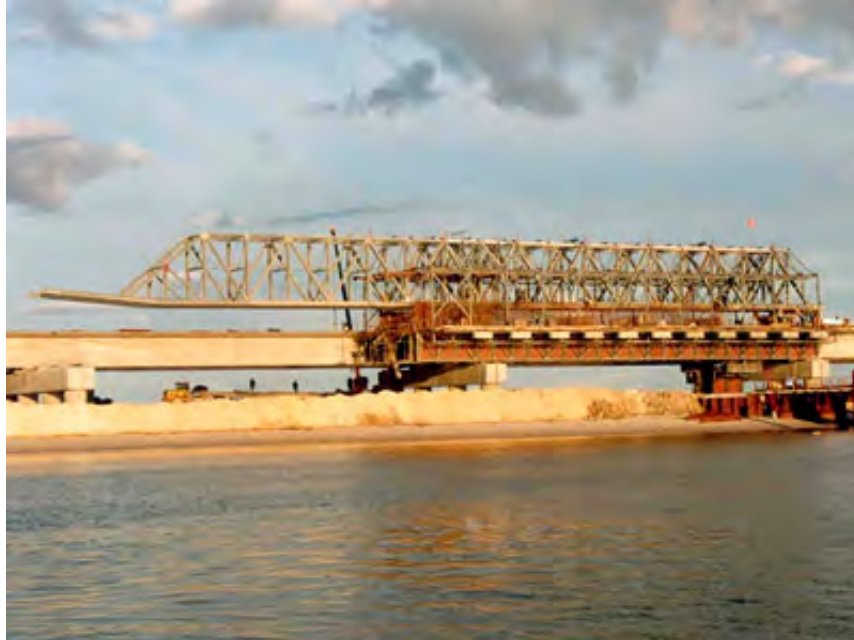
Figura 102 – Viga de lançamento
