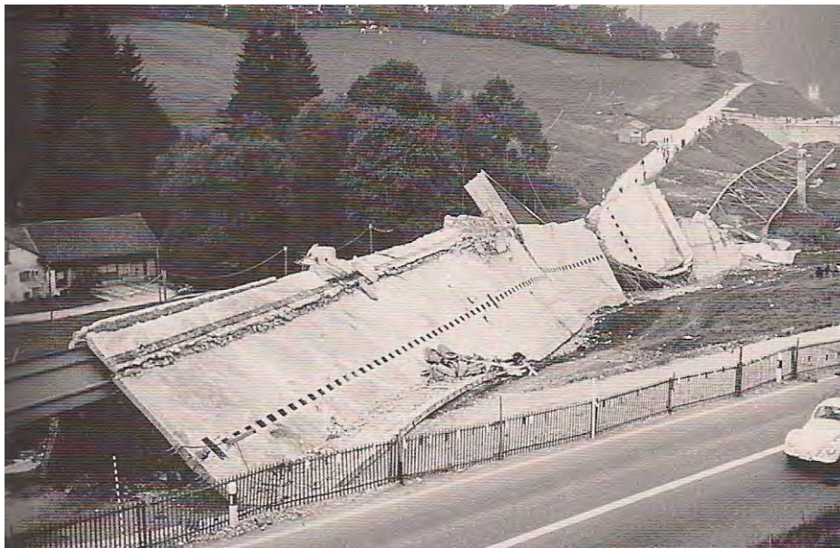
Figura 132 – Ponte Valagin depois do colapso
