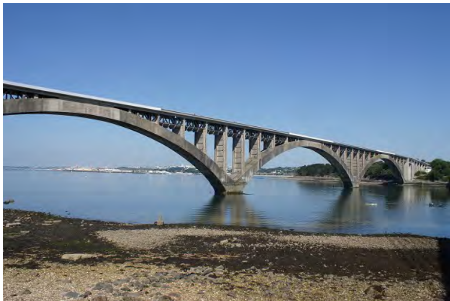
Figura 25 – Ponte Plougastel em Brest, França
