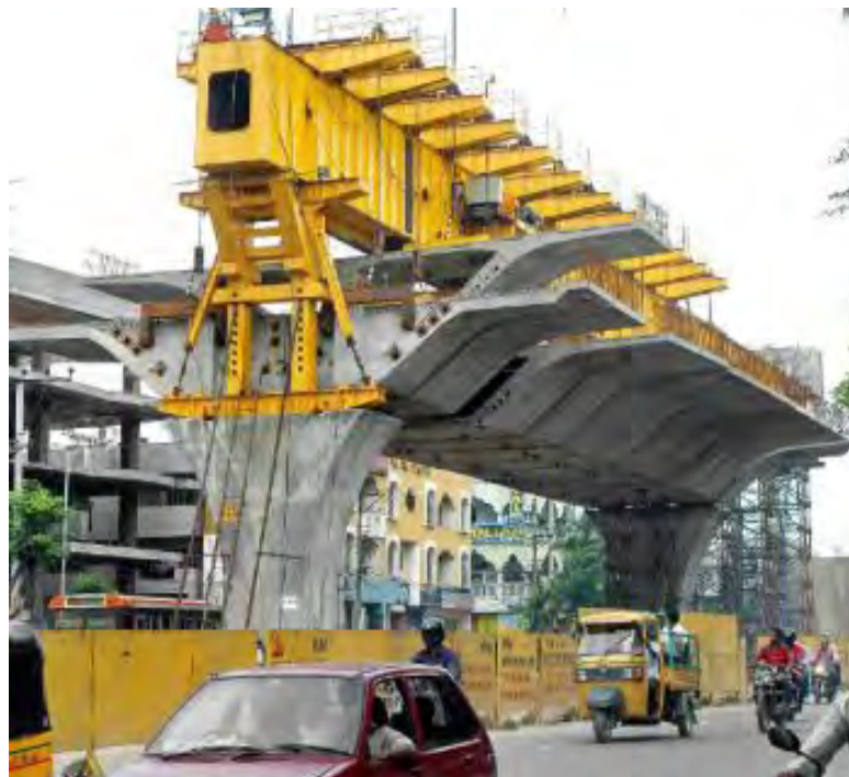
Figura 48 – Lançadeira para colocação das aduelas pré-fabricadas
