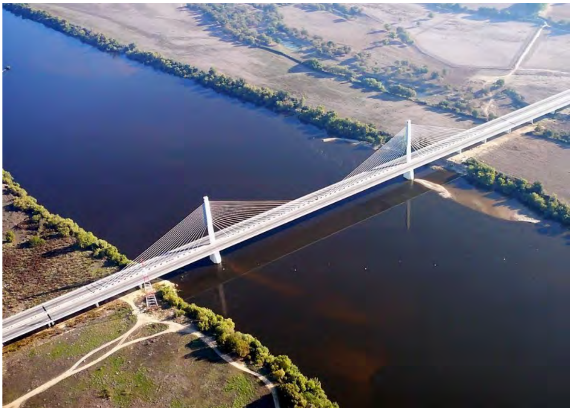
Figura 113 – Ponte Salgueiro Maia, Santarém
