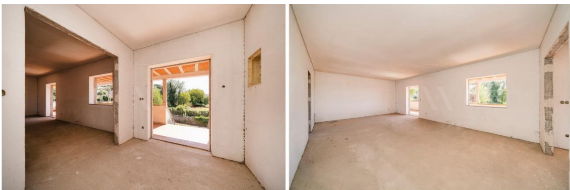
Fotografia 10. [esquerda] Hall - Piso Superior. Fonte: Cliente. [1]
