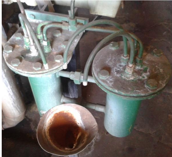
Figura 12 - Orifício da Purga
