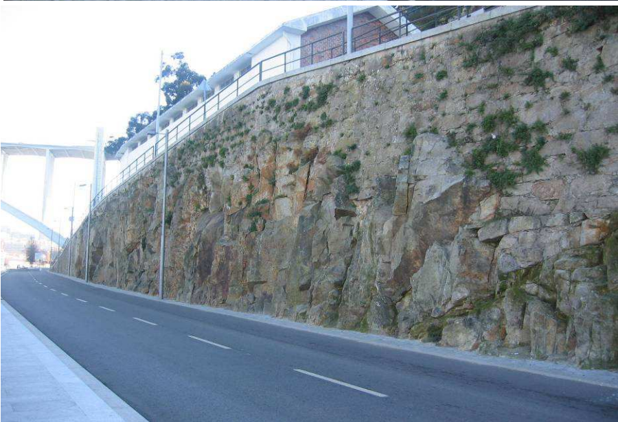
Figura 48 – Vistas gerais dos três taludes em estudo.
