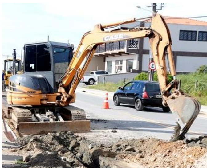
Figura 4.14 – Miniescavadora com balde ( http://www.aguasdesaofranciscodosul.com.br ).
