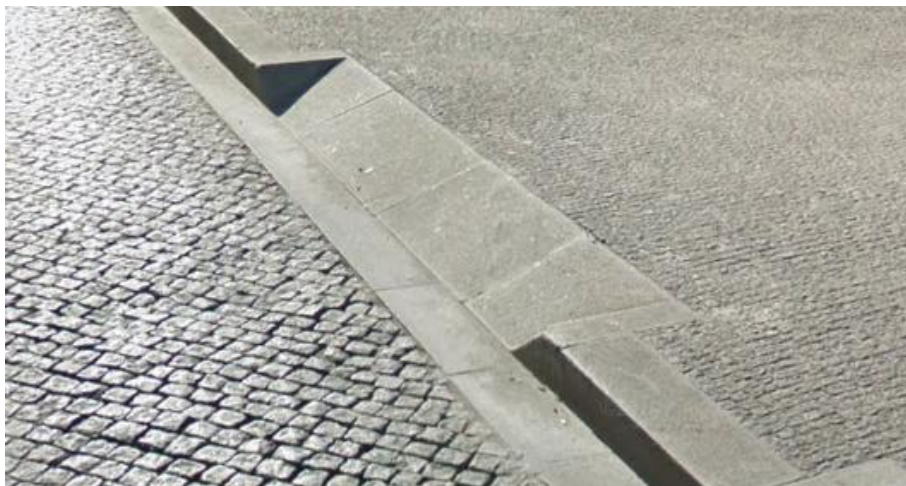
Figura 4.5 – Guia de rampa em granito instalada pela Águas do Porto.
