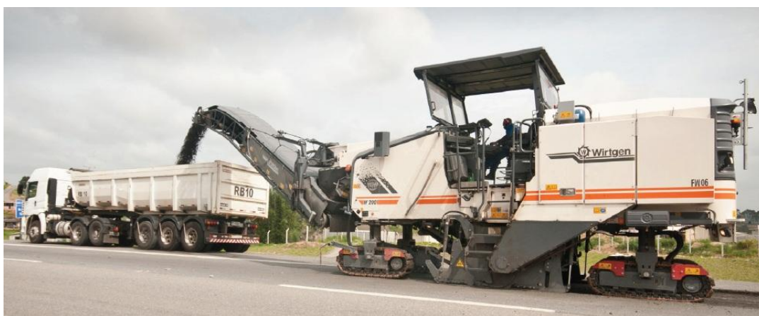
Figura 4.12 – Fresagem do pavimento betuminoso e depósito em camião basculante ( http://www.engenhariaeconstrucao.com ).
