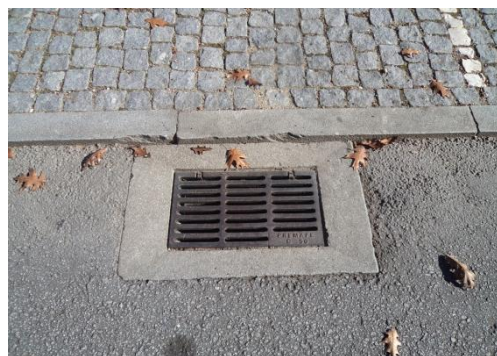
b) Sumidouro junto a baia de estacionamento (SE)
