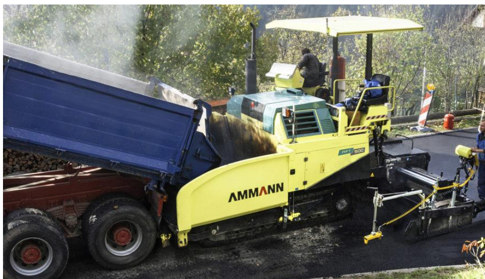
Figura 4.22 – Descarga de mistura betuminosa e seu espalhamento por pavimentadora ( https://www.industriahoje.com.br ).
