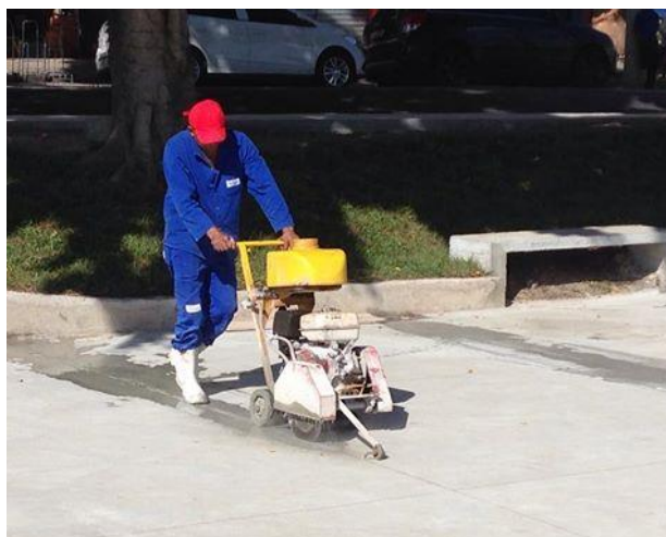
Figura 4.21 – Abertura de juntas de dilatação em piso de betão ( https://scontent-sea1-1.cdninstagram.com ).
