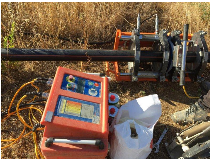
Figura 4.33 – Soldadura topo a topo de tubagem de PEAD ( https://media.licdn.com ).
