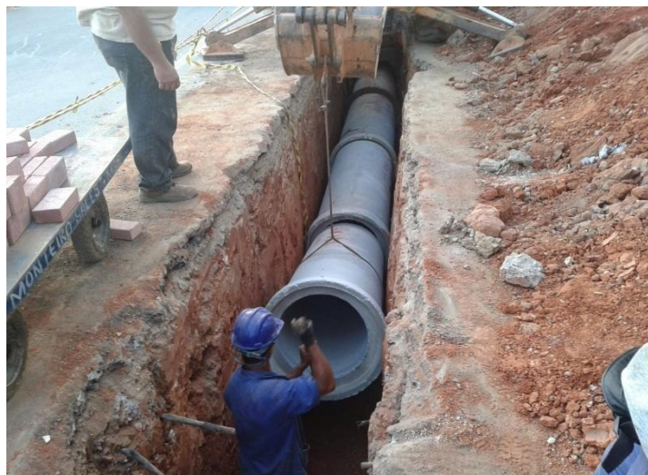
Figura AI 11 – Implantação de manilhas de betão em obra de águas pluviais ( http://monteirosales.blogspot.pt ).
