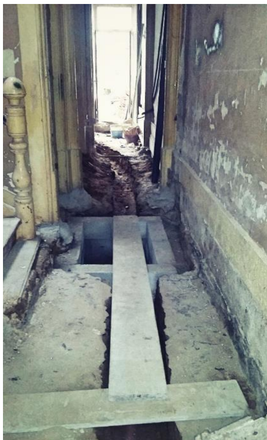
a) Execução de caixas de visita
