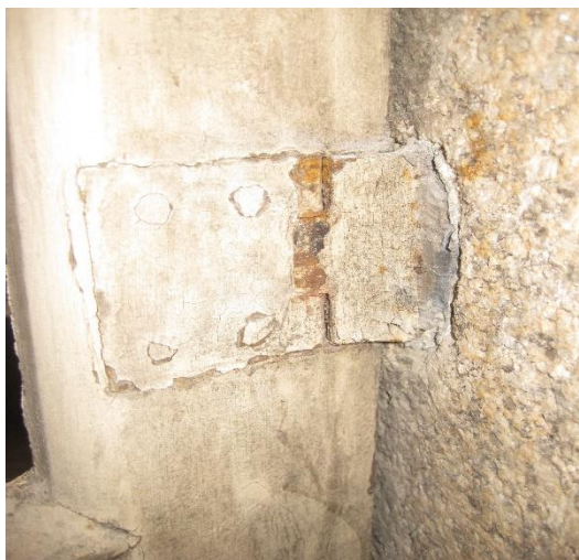
a) Fixação da caixilharia da janela.
