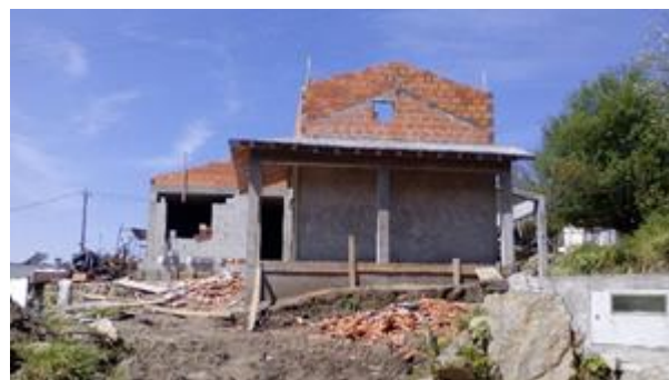
d) Trabalhos de alvenaria na fachada principal
