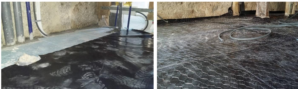
a) Aplicação de Floormate e manga plástica
