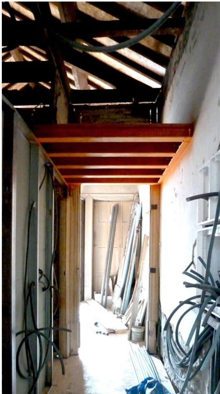
Figura 4.21 – Estrutura do Mezzanine.
