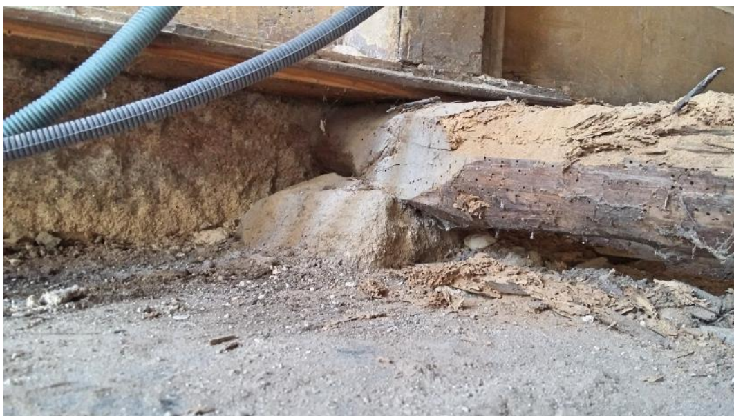
a) Pormenor da viga do piso térreo a descarregar na parede de meação.
