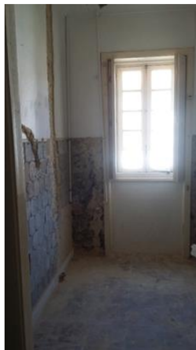
c) Remoção do cerâmico do pavimento
