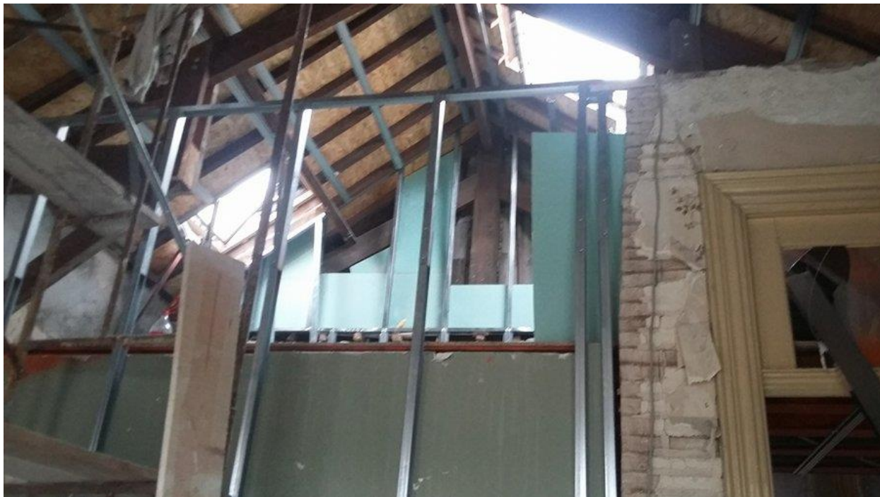
Figura 4.20 – Janelas VELUX na cobertura.
