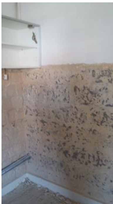
b) Remoção do cerâmico da parede
