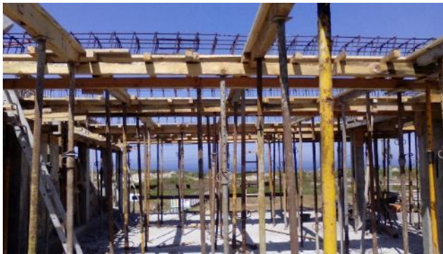
a) Escoramento cimbre
