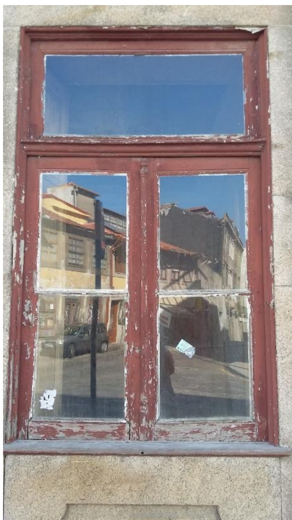
a) Caixilharia de madeira
