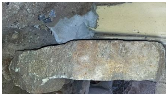
d) Pedra retirada do pavimento do piso 0
