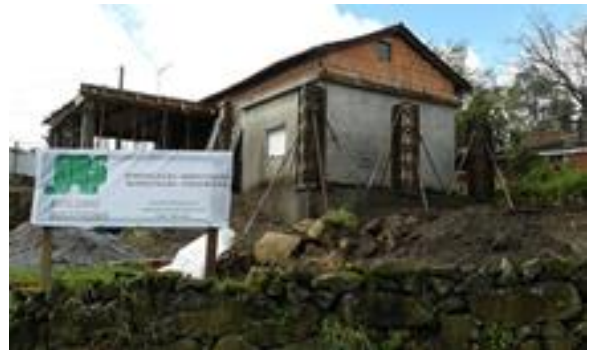
b) Execução de pilares na zona do alpendre
