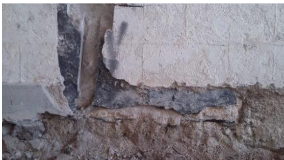
c) Paredes de meação em pedra
