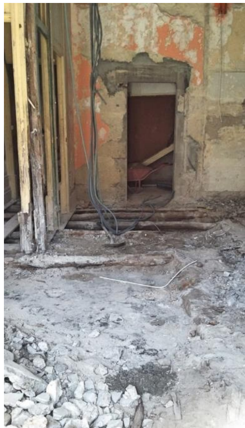
b) Levantamento após demolição.
