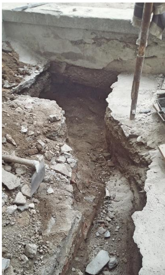
b) Abertura de valas para tubagem
