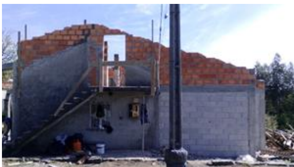
c) Trabalhos de alvenaria na fachada lateral
