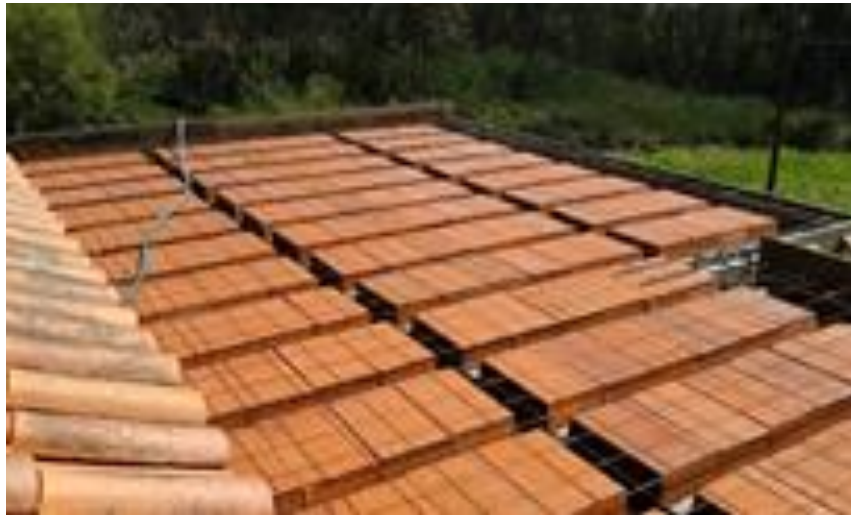
Figura 2.11 – Abobadilhas para execução da cobertura.
