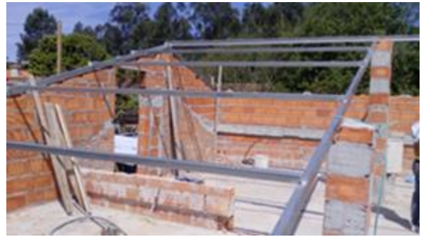
b) Estrutura metálica para suporte estrutural.
