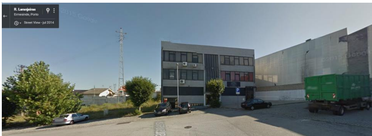
Figura 2.3 - Vista de Rua da Sede da GNS Building Solutions (julho de 2014, Google Maps).
