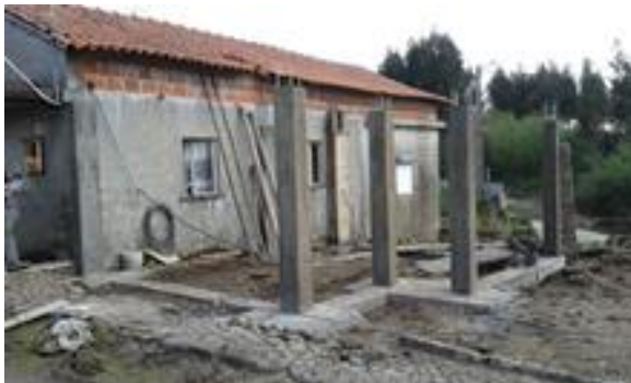
a) Execução dos pilares na zona do quarto
