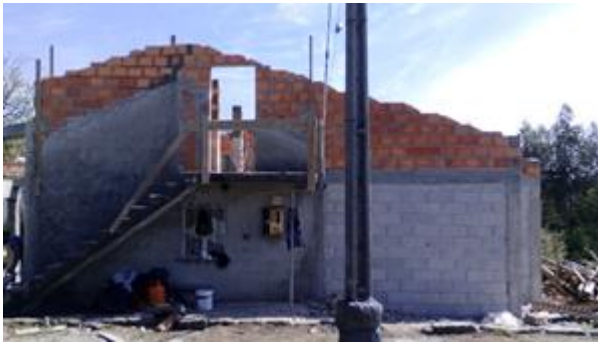
a) Colocação de novas asnas para suporte da nova cobertura.
