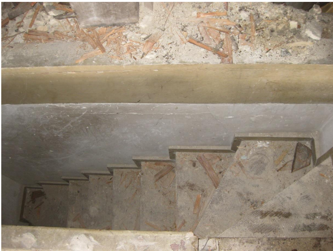
c) Escada provisória de acesso à cobertura
