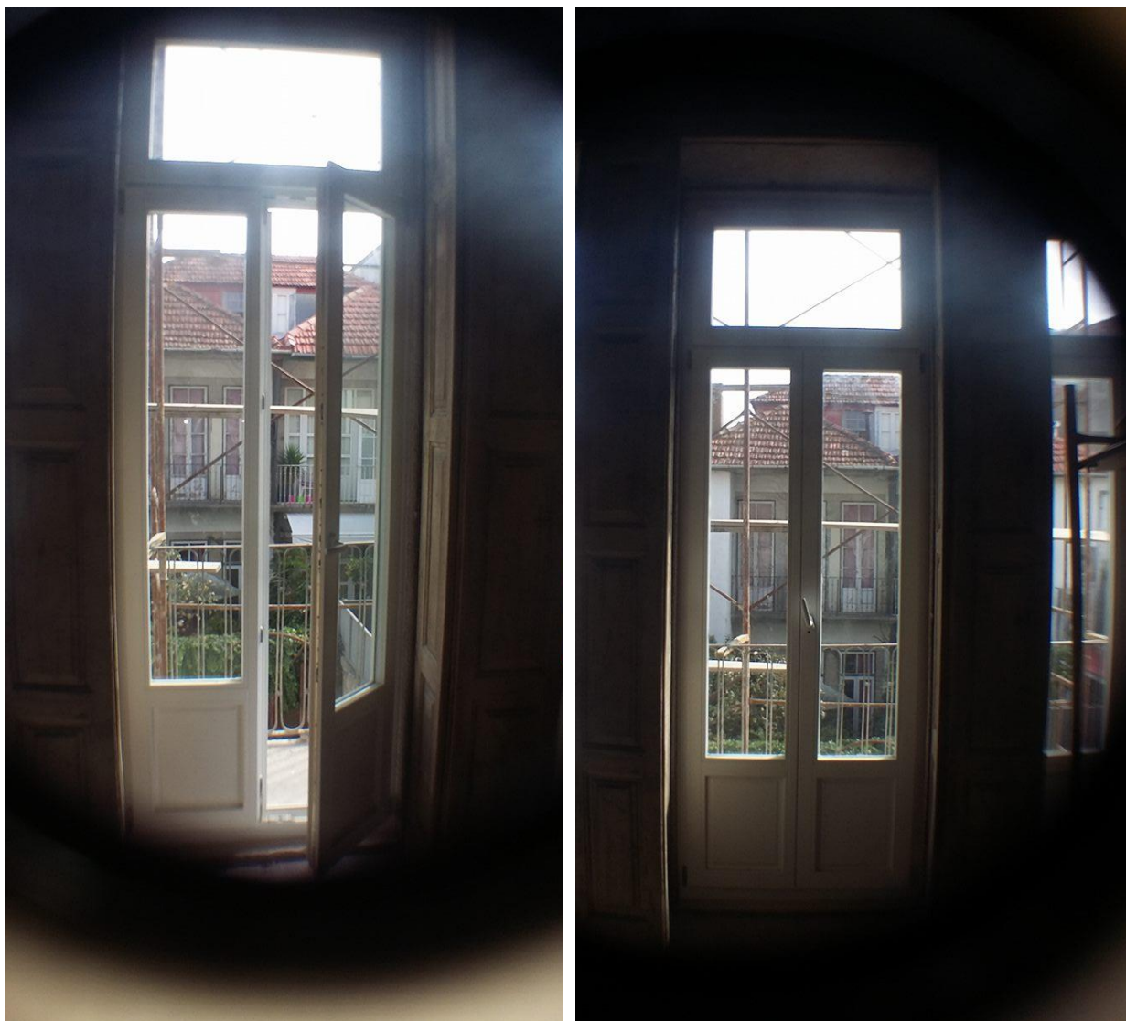
Figura 4.23 - Caixilharias novas (aberta e fechada).
