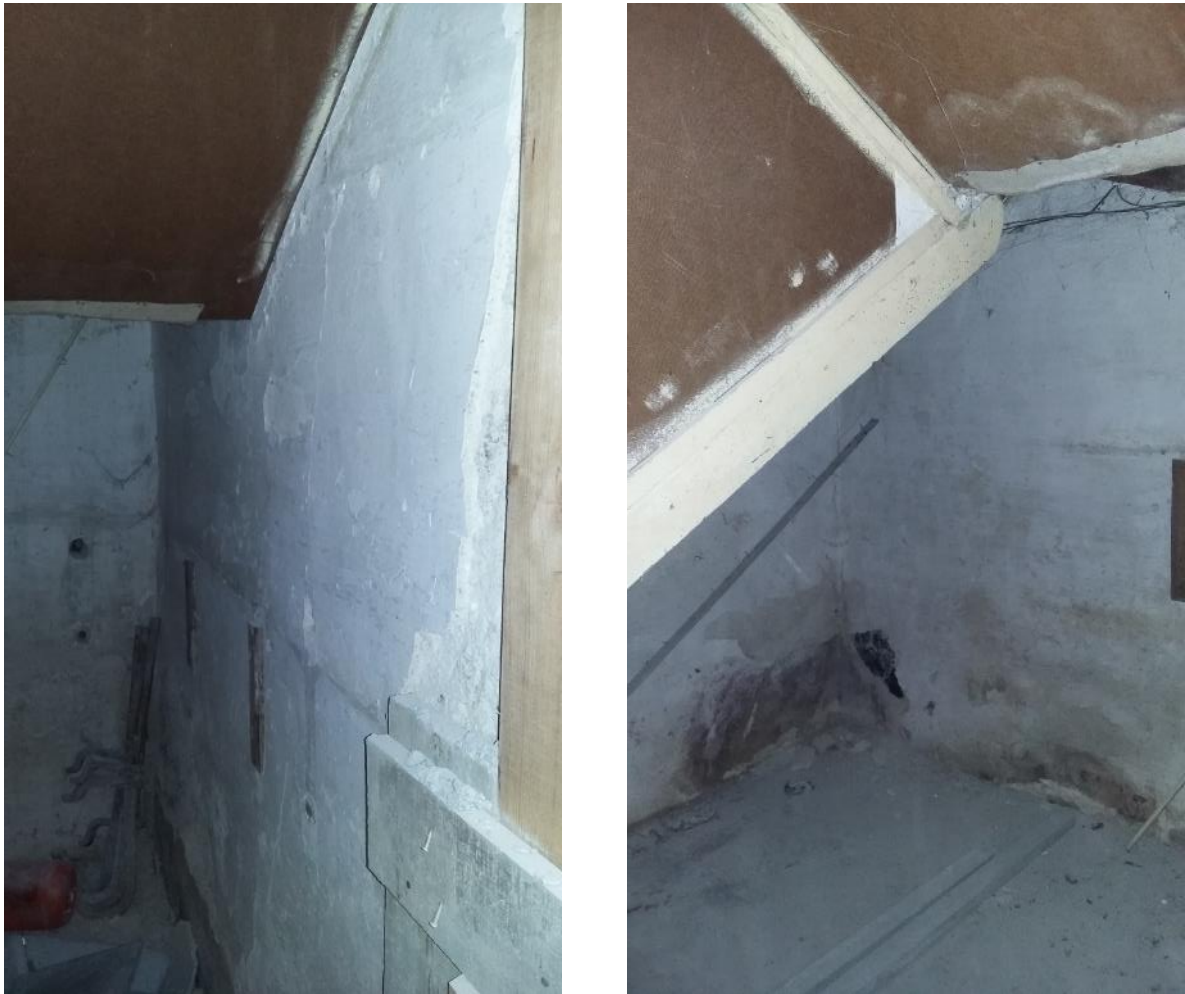
Figura 4.6 – Parede de pedra da caixa de escadas.
