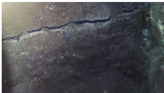
b) Camada de betume entre fundações em pedra
