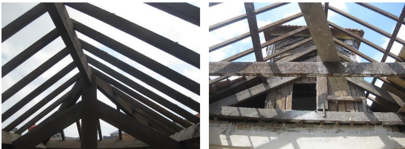
Figura 4.7 - Estrutura da cobertura.
