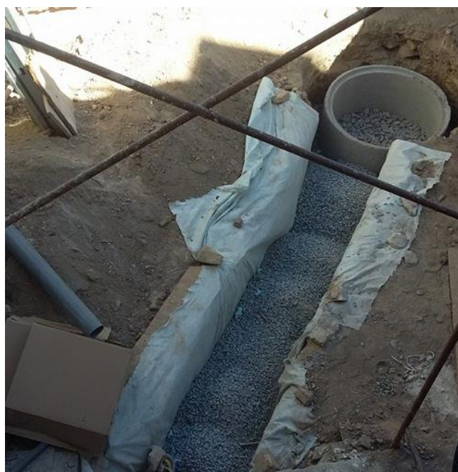
Figura 4.27 – Preenchimento da vala com brita
