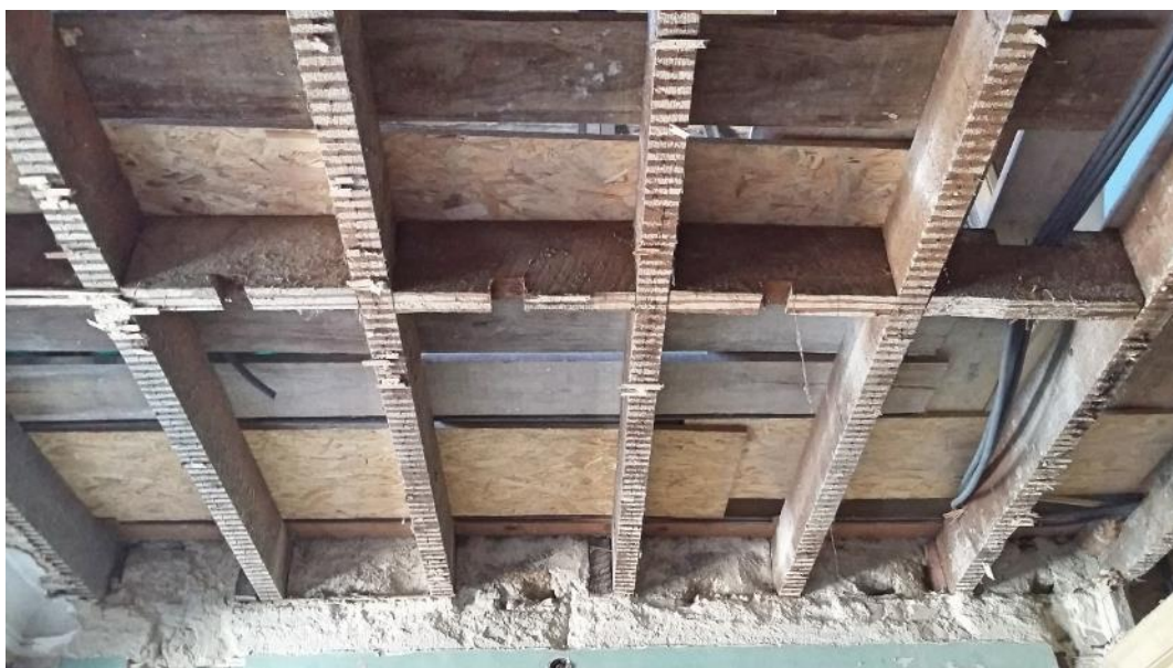
b) Viga do pavimento do piso 1.
