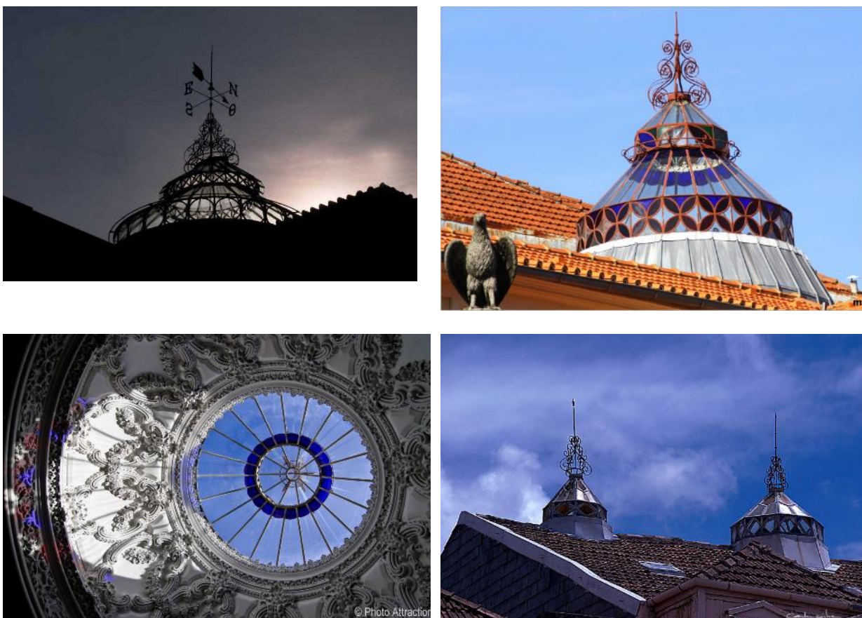
Figura 3.16 – Exemplos de clarabóias complexas estruturais na cidade de Porto.
