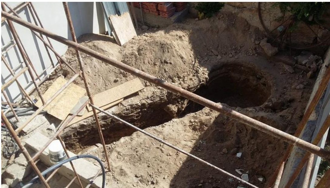
Figura 4.26 – Abertura da vala e poço.
