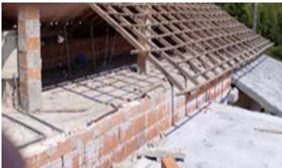
c) Ripas e contra-ripas para colocação de painel.
