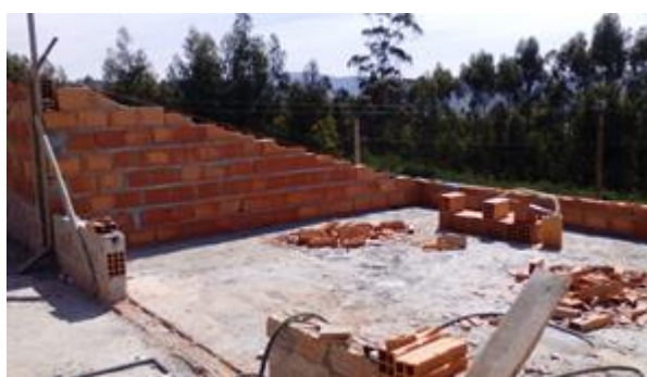
b) Execução de parede na zona da cobertura
