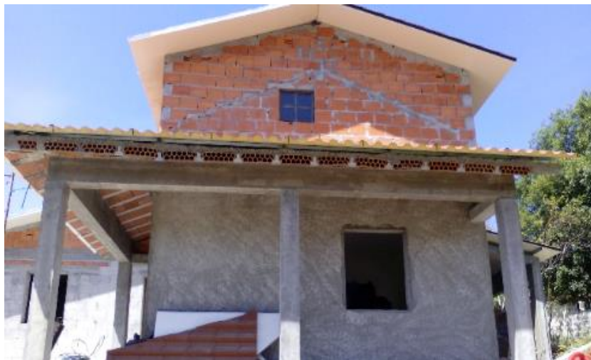
Figura 2.17 – Finalização dos trabalhos de alvenaria.
