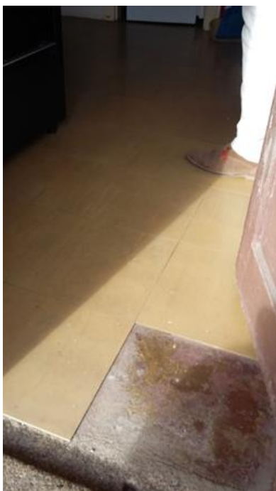
a) Pavimento existente
