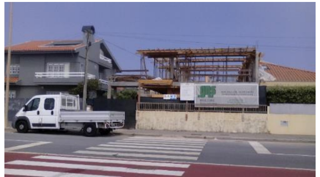
b) Escoramento do cimbre – Vista rua
