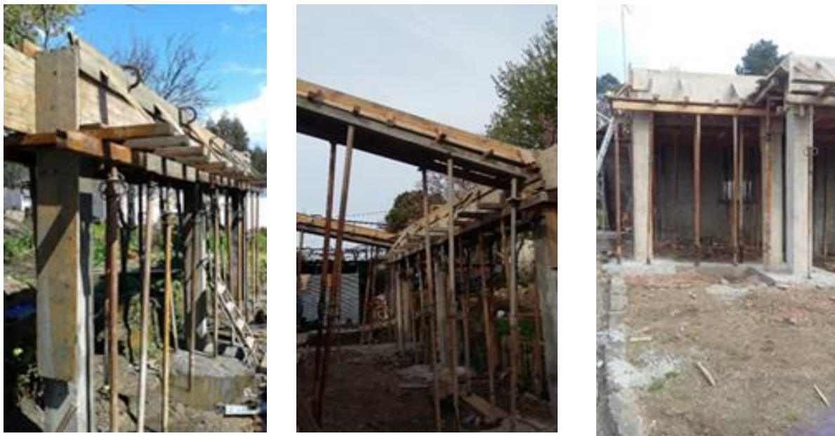
Figura 2.10 – Fase de execução de pilares – diferentes perspetivas.
