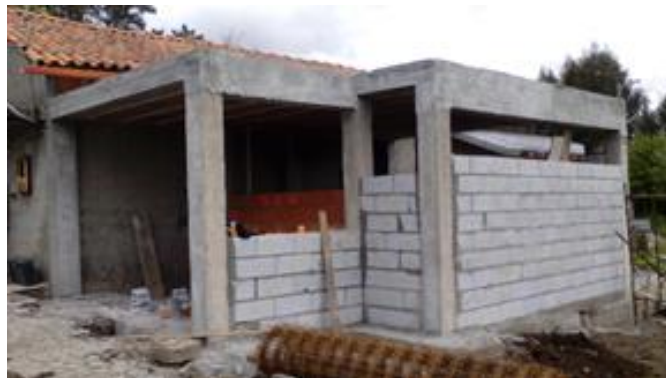
c) Continuação dos trabalhos de alvenaria na zona do quarto
