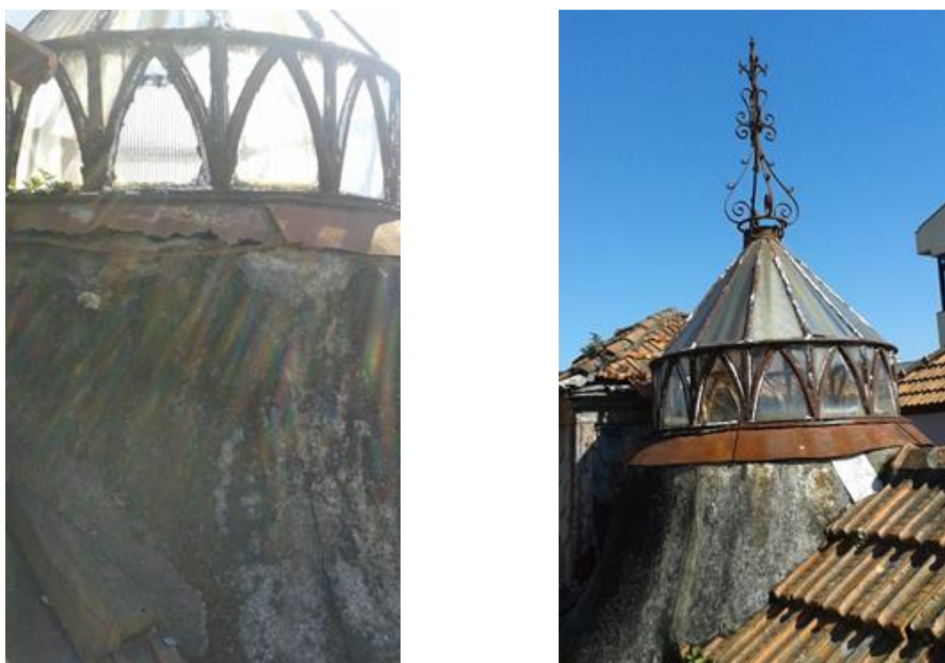
Figura 4.8 – Clarabóia vista do exterior.
