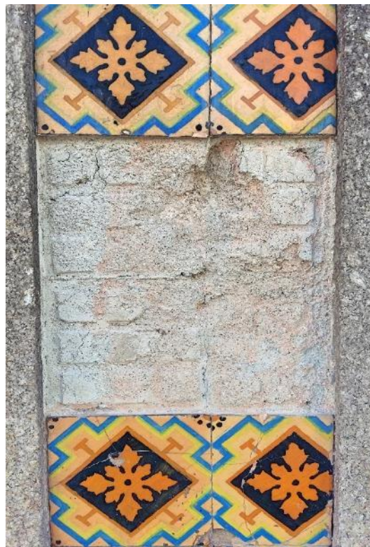
b) Fixação do azulejo na fachada – Saibro
