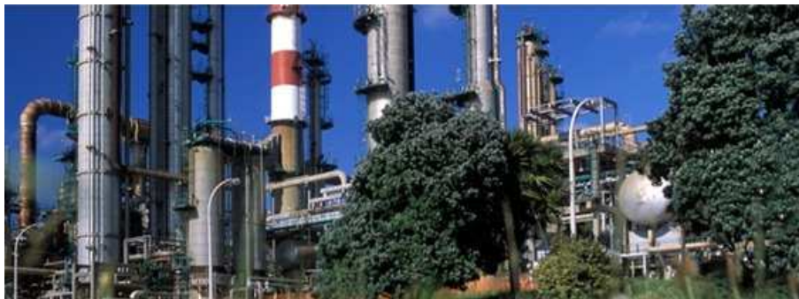
Figura 1.2- Fábrica de Aromáticos da Refinaria de Matosinhos (Galp Energia, 2013).
