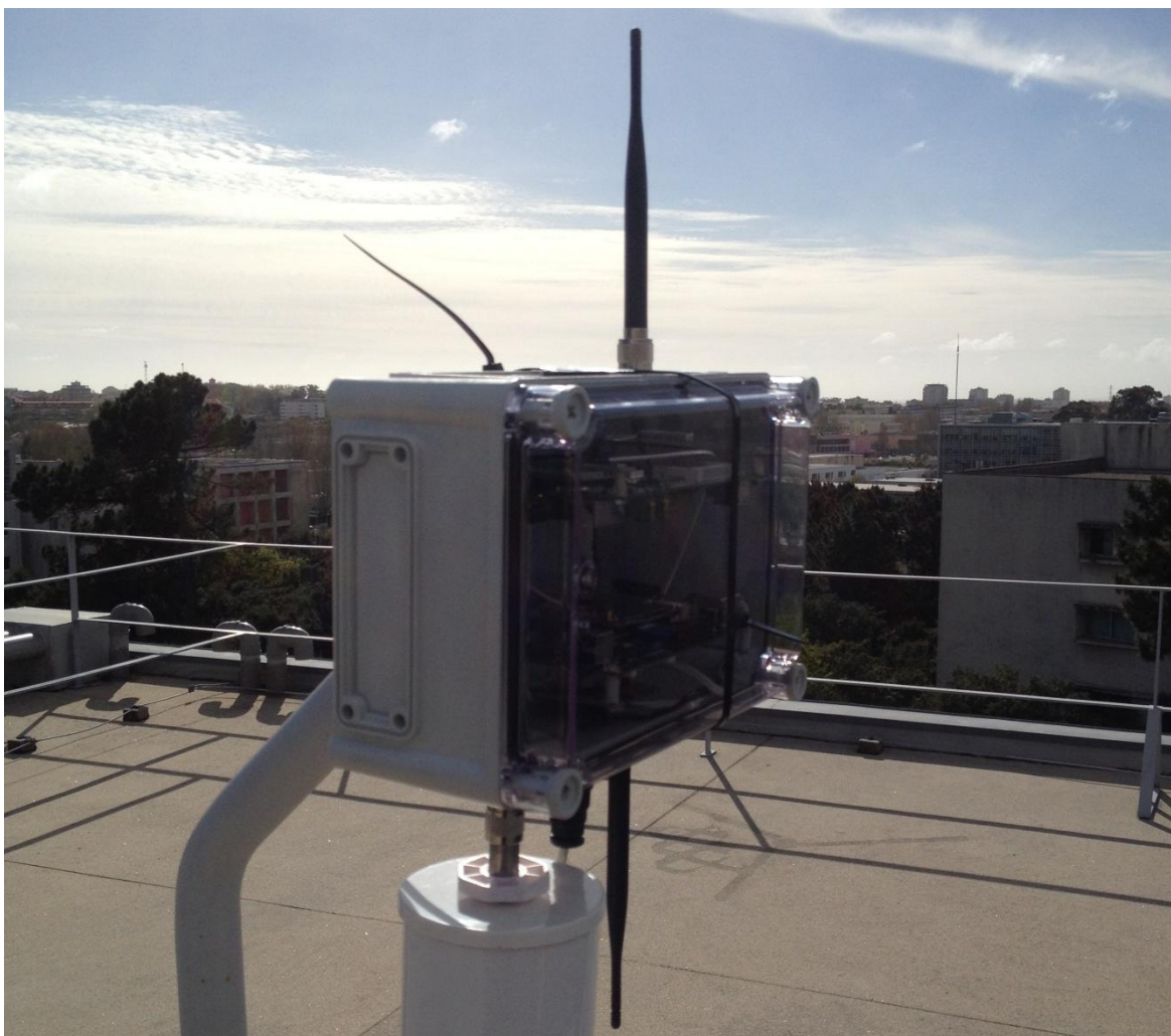
Figura 27 Fixação caixa estanque em mastro
