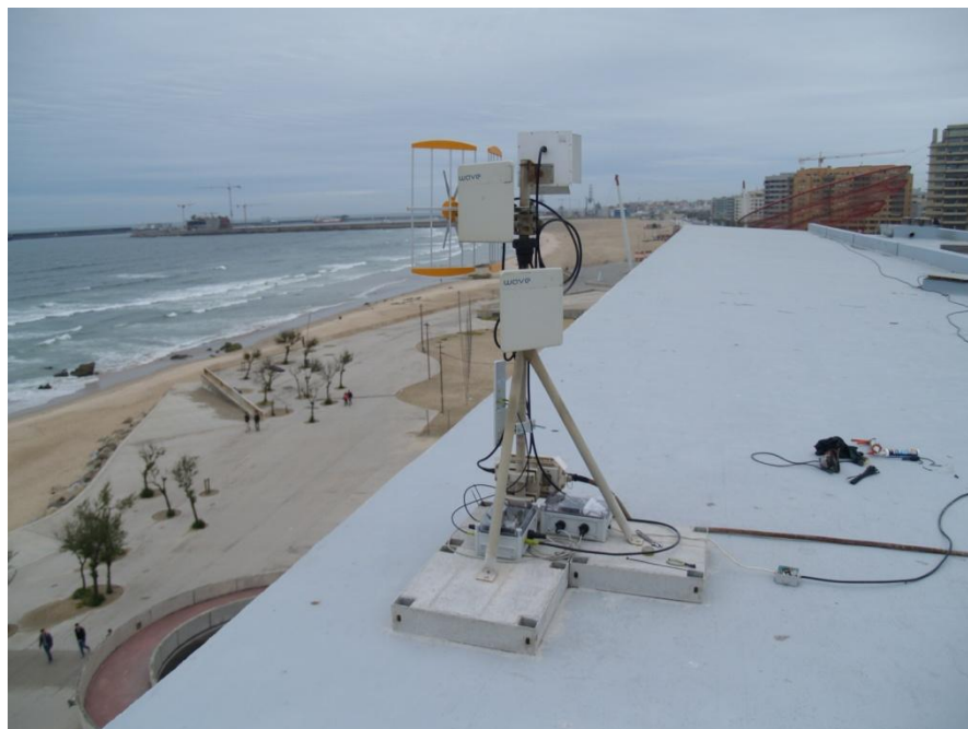
Figura 35 Montagem do nó de terra no topo do edifício transparente
