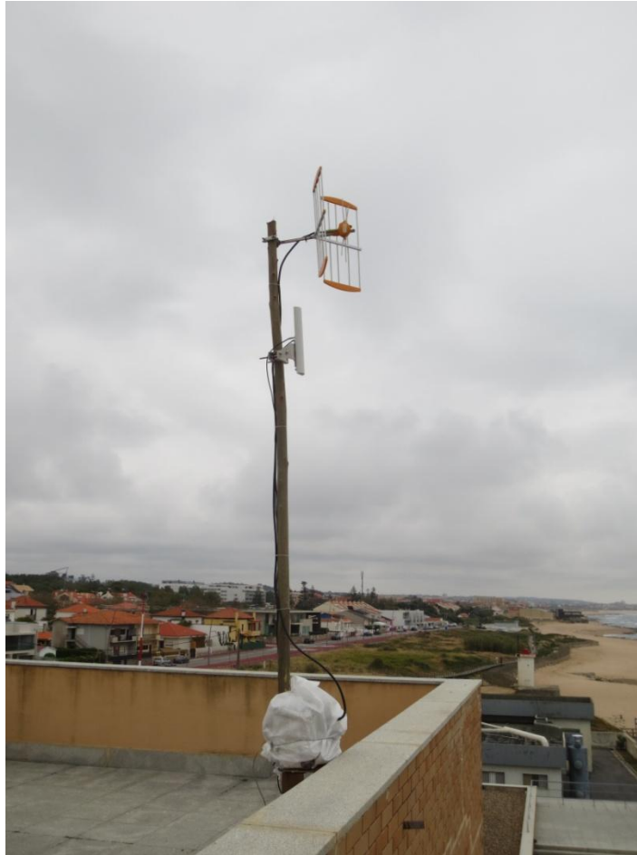
Figura 64 Montagem equipamento terra
