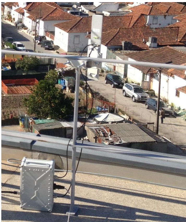
Figura 34 Montagem da caixa e antena sectorial
