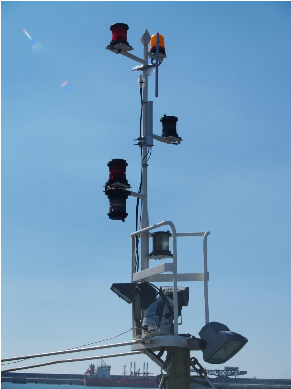
Figura 37 Montagem do nó de barco
