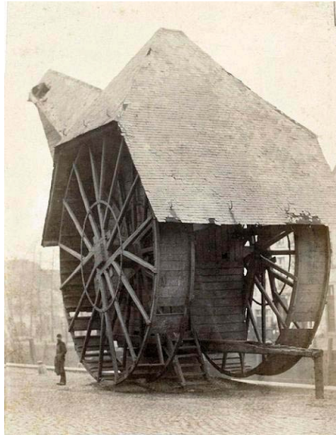
Figura 6 - Guindaste de estaleiro / porto [3]
