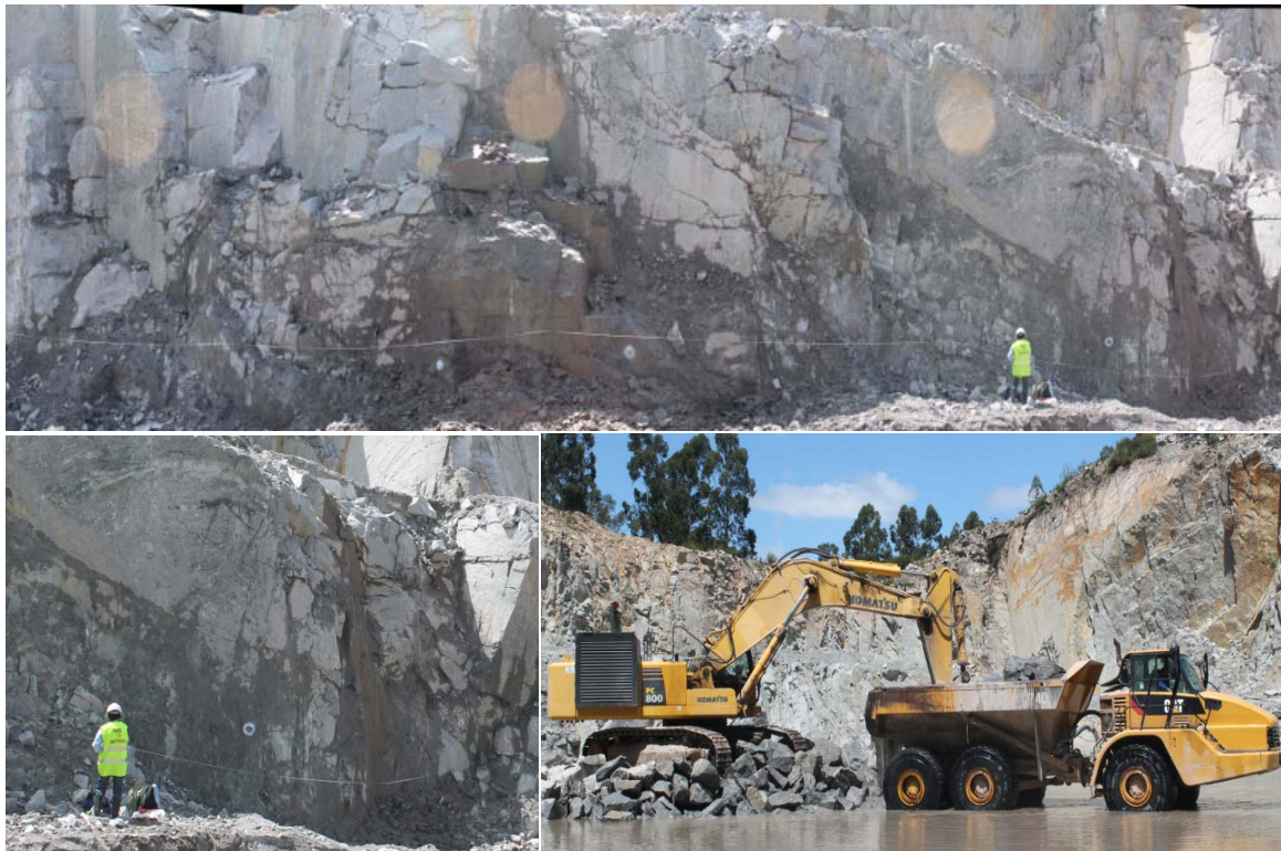
Figura 46 – Aplicação da técnica da amostragem linear (scanline) e laboração.
