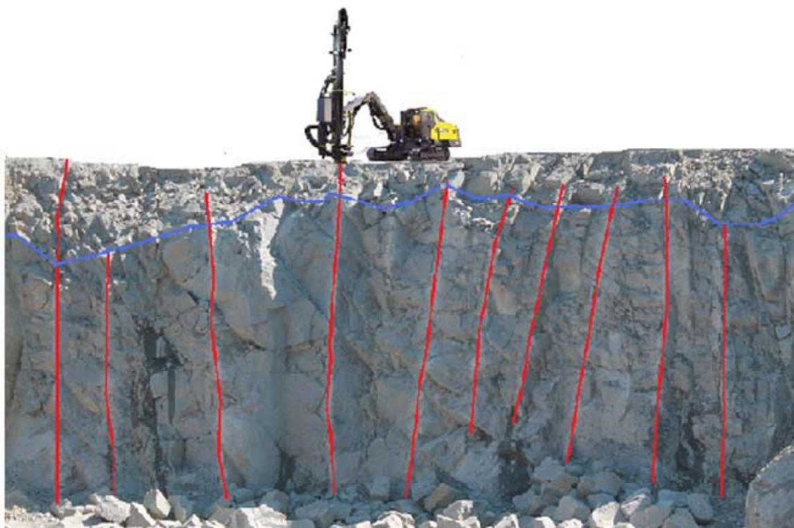
Figura 25- Face exposta de bancada, furos e respetivos desvios. (Pedreira da Secil, Famalicão, Julho de 2013)
