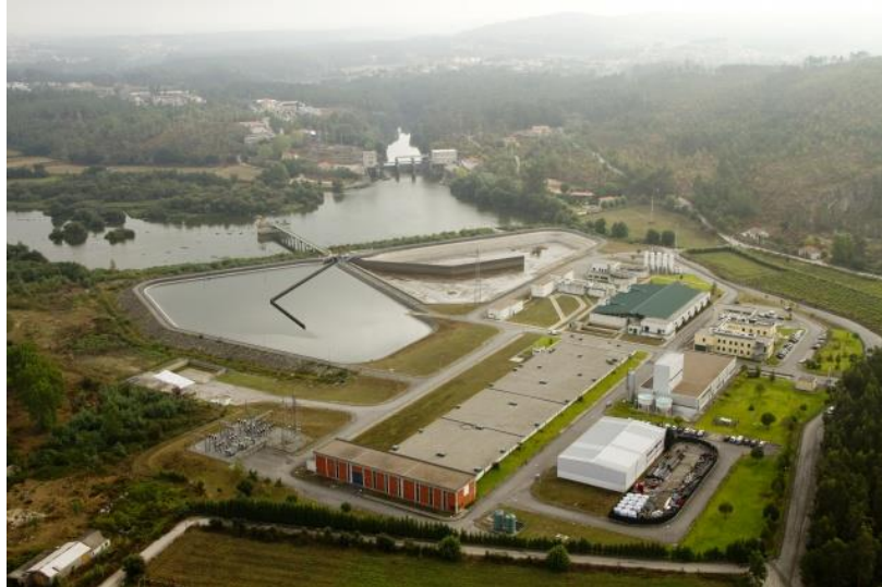
Figura 1.4 - ETA Areias de Vilar, Barcelos. [2]
