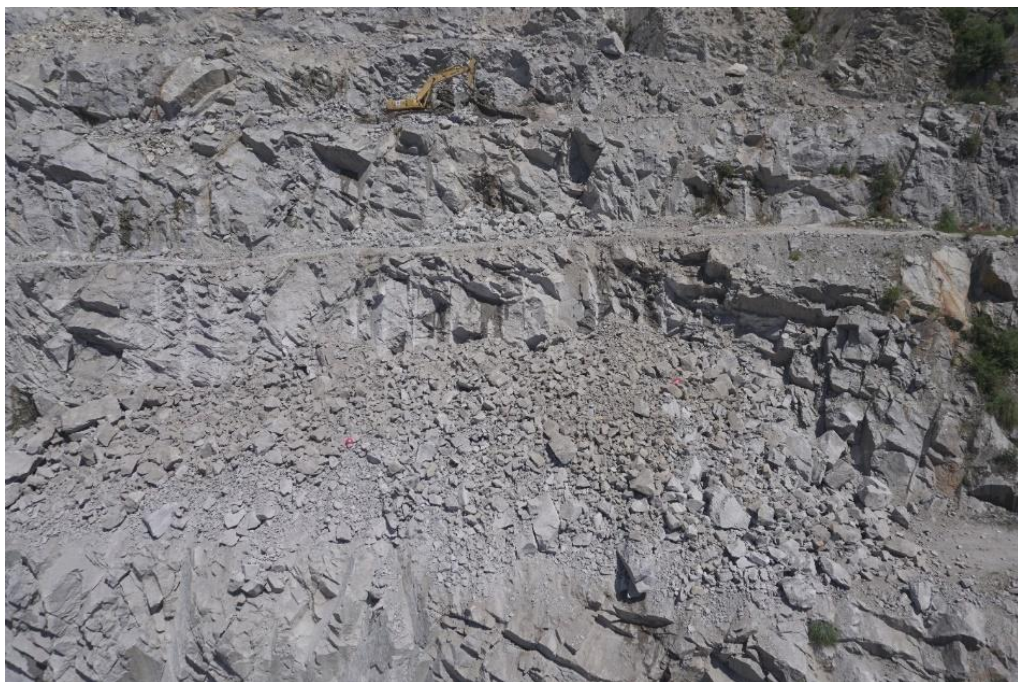
Figura 67 – Aspeto da bancada após a realização do desmonte com detonadores não elétricos e fragmentação de material obtida
