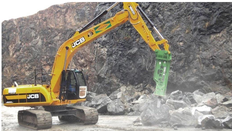
Figura 23 – Execução de desmorte secundário num bloco de grandes dimensões com recurso a meios mecânicos (fonte: http://revista.webpesados.com.br/rompedor-hidraulico-aumenta-seguranca-e-produtividade-no-desmorte/ )
