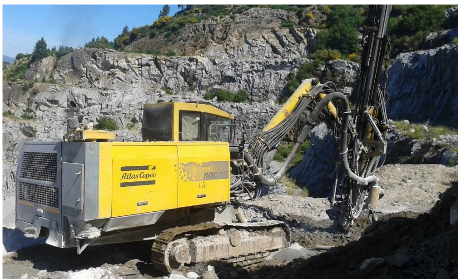
Figura 58 – Equipamento de perfuração Atlas Copco Roc D7
