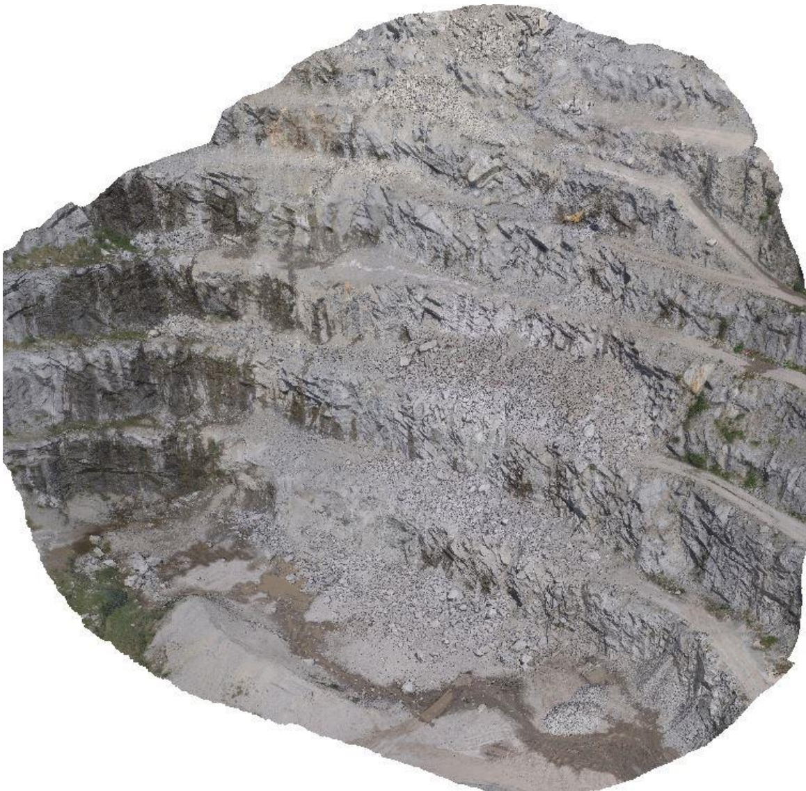
Figura 74 – Modelo 3D do flanco de exploração da Pedreira de Serdedelo elaborado com recurso ao software Agisoft Photoscan destaque para o resultado da pega com detonadores não elétricos
