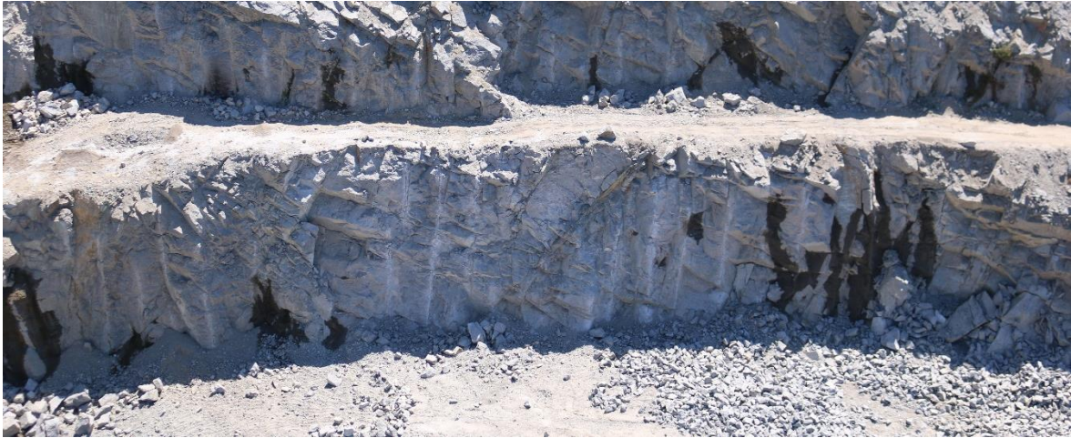
Figura 68 - Aspeto da bancada antes de se realizar o desmonte com detonadores eletrónicos
