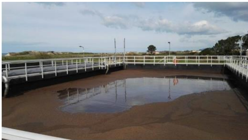
Figura 2-3- Tanque SBR
