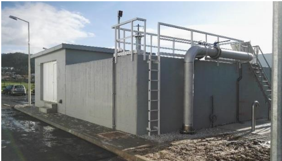
Figura 3-9- Tanque de Equalização.
