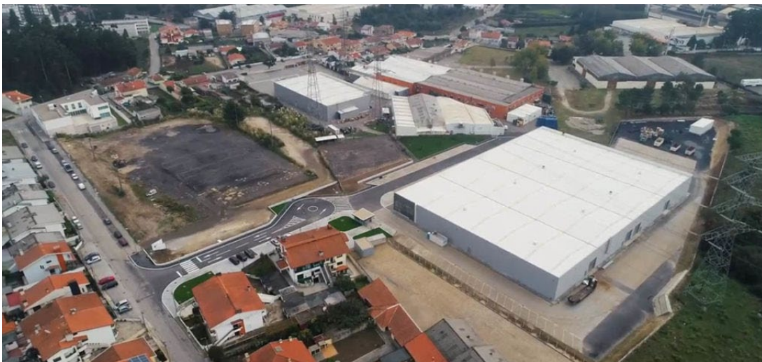
Figura 18 - Instalações Fico Cables [100]
