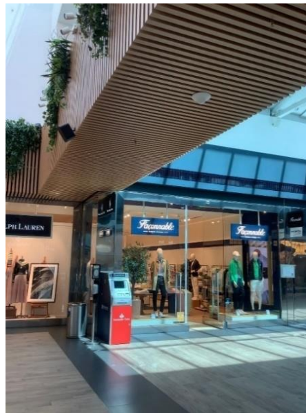
Figura 9- Sprinklers e detetores de incêndio
