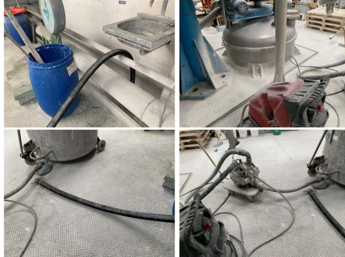
Figura 33 Implementação da proposta recorrendo a equipamento existente
