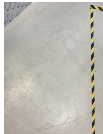
Figura 17 - Limpeza do chão da oficina
