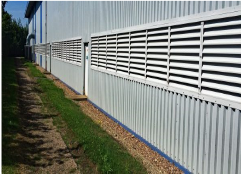
Figura 5 Varrimento passivo, com aberturas para saída de fumo através de aberturas na fachada [13]
