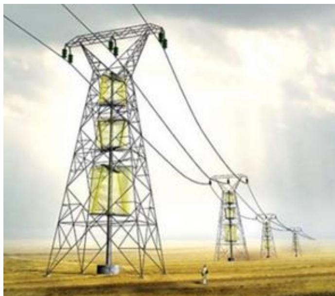
Figura 25 – Linhas de transporte de energia eléctrica
