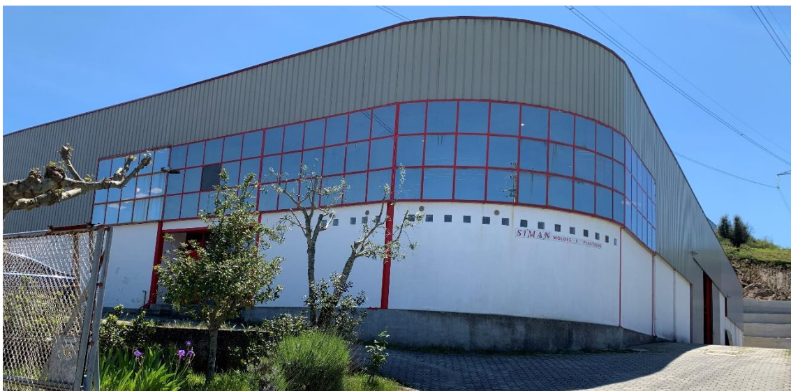
Figura 42 - Exterior das instalações SIMAN - Sociedade de Moldes de Mansores, Unipessoal, Lda
