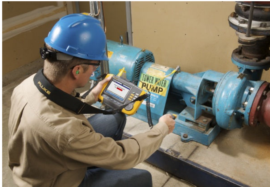
Figura 3 - Utilização prática do Fluke 810 (QEnergia, 2012).
