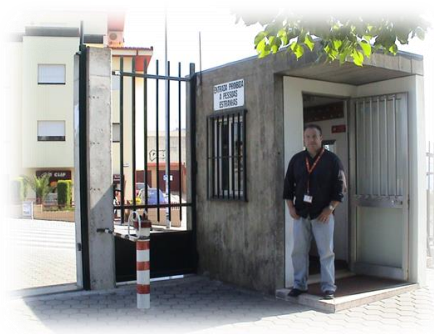
Portão de Entrada
