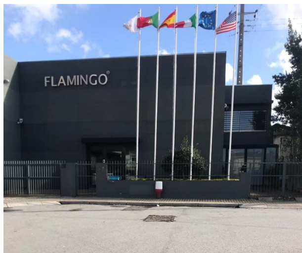
Figura 2 - Sede da empresa em Rio Tinto (Portugal).
