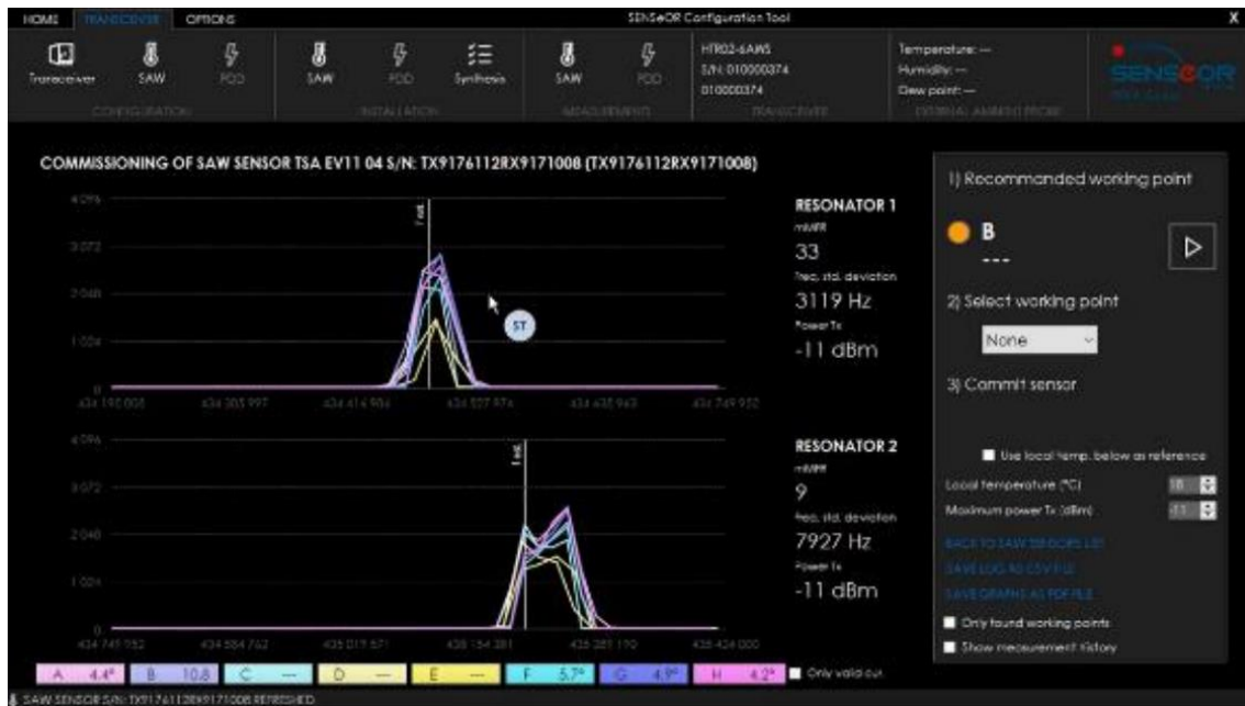
Figura 51 - Comissionamento do sensor “ref 04” no Compartimento de barramento.
