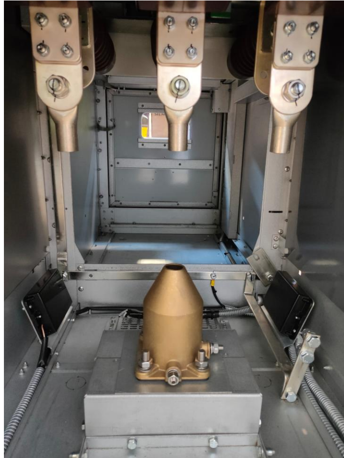
Figura 54 - Disposição das antenas no Compartimento de cabos.
