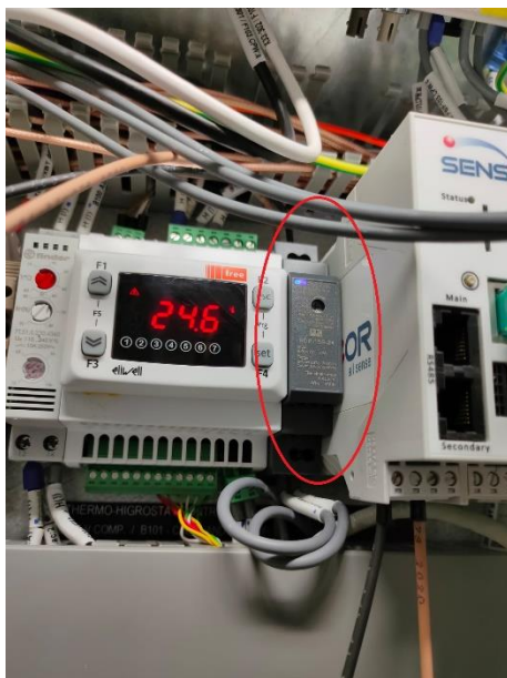
Figura 58 - Fonte externa para alimentação do HTR02.
