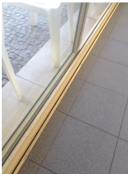
Figura 23- Pormenor envidraçado edifício existente
