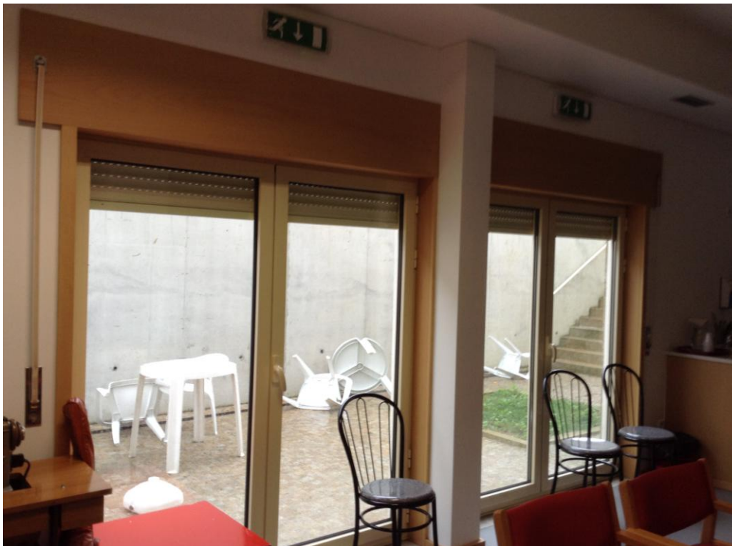
Figura 8- Portas na cave de acesso ao exterior
