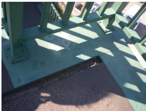
Figura 2.14 - Vista das caleiras existentes no pavimento
