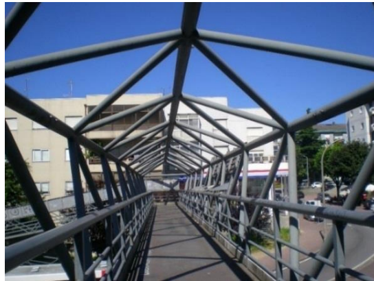
Figura 2.8 - Passagem junto ao Bragaparque constituída por perfis de secção circular
