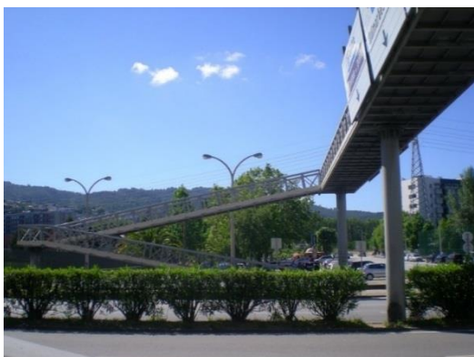
a) Passagem Superior Pedonal sobre a Rodovia
