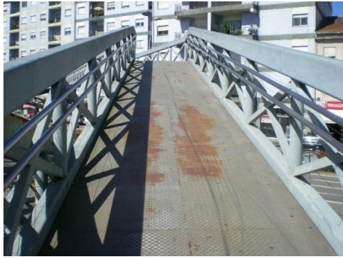
a) Passagem Superior Pedonal junto à Estação de Comboios
