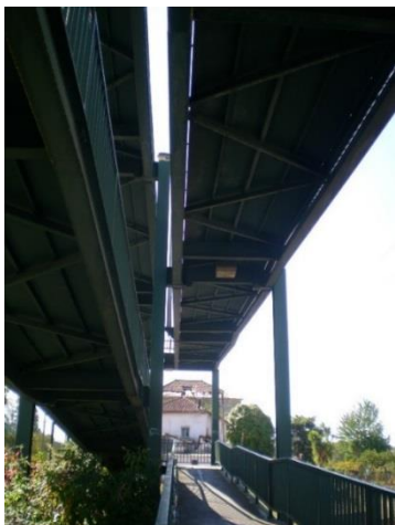
Figura 2.12 - Vista da ligação dos pilares às vigas de rampa, lateralmente
