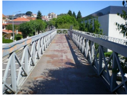
b) Passagem Superior Pedonal junto ao Tribunal
