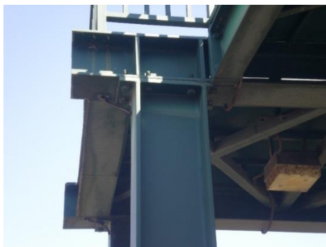
Figura 2.15 - Vista do fio-de-terra e da iluminação na estrutura
