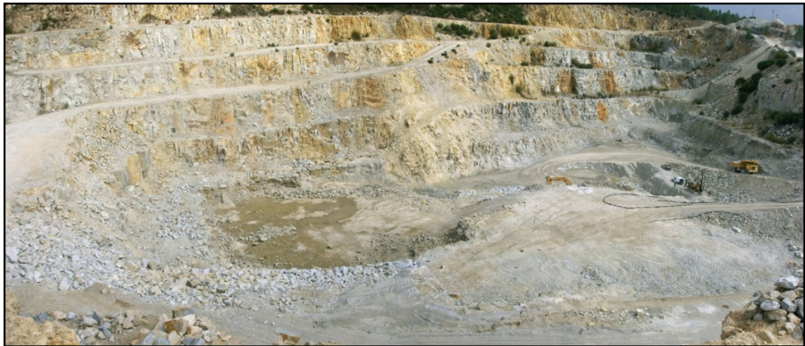
Figura 13. Panorâmica da pedreira nº 5750 de Monteiras, vista de Sul.
