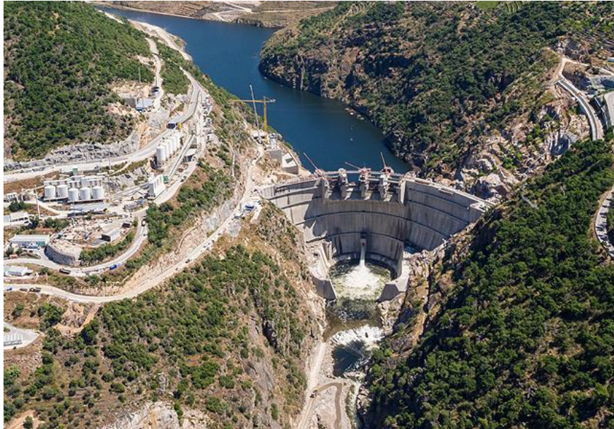
Figura 2.5 - Barragem de Foz Tua (EDP, 2017)
