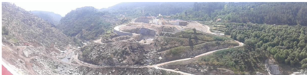
Figura 2.3 – Construção das novas barragens do Tâmega
