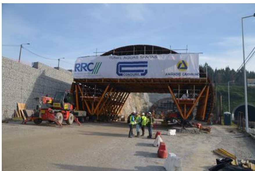
Figura 2.4 - Túnel de Águas Santas
