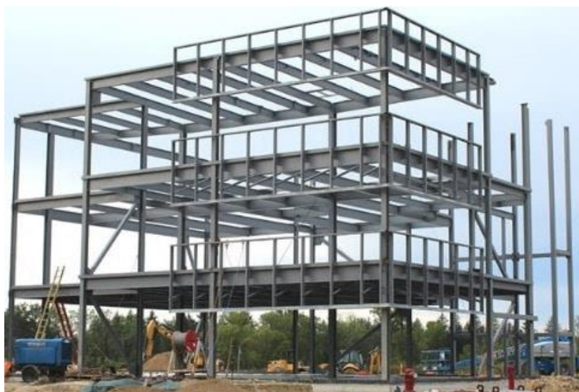
Figura 9: Construção de um edifício recorrendo a uma estrutura metálica [27].
