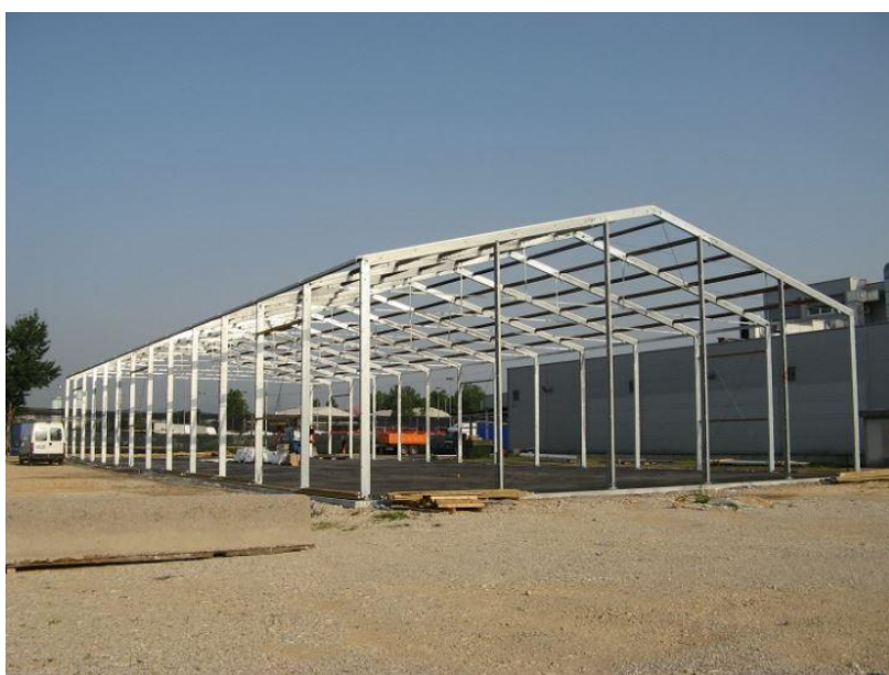
Figura 10: Estrutura metálica de um armazém industrial [31].
