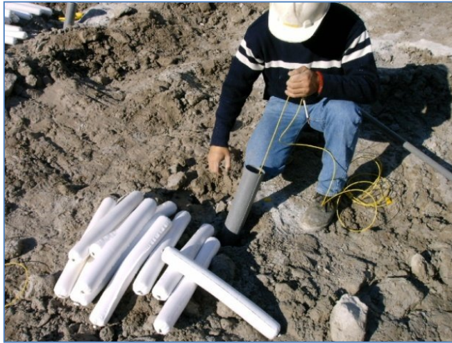
Figura 73 – Colocação do explosivo dentro da cada um dos furos a detonar.
