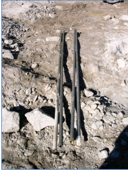
Figura 68 – Varas para desencravamento dos cartuchos de explosivo nos furos.
