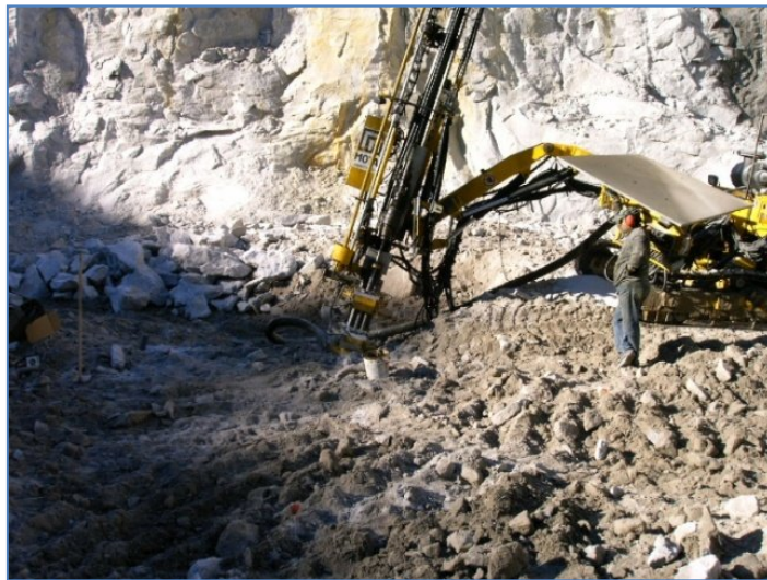
Figura 61 – Equipamento de perfuração com a inclinação e direcção desejada.
