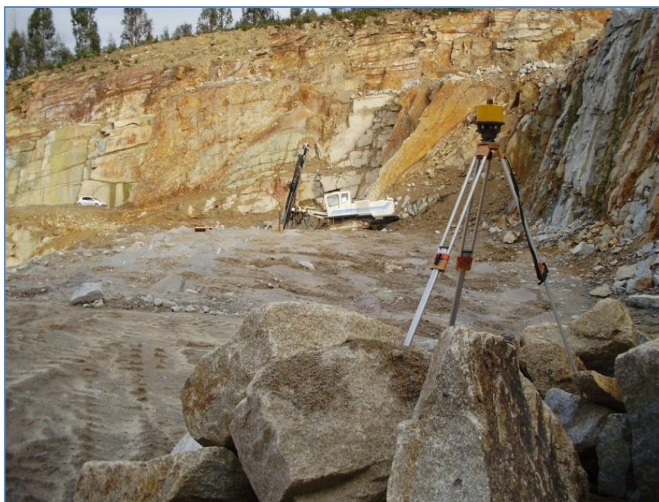
Figura 13 – Sistema do “laser” plano a trabalhar em conjunto com o equipamento de perfuração em modo automático.
