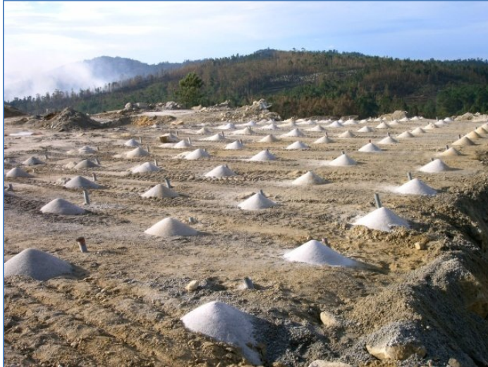
Figura 62 – Colocação dos tubos de protecção.
