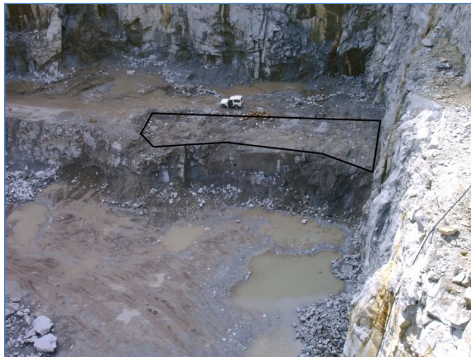
Figura 48 – Afectação da zona superficial.
