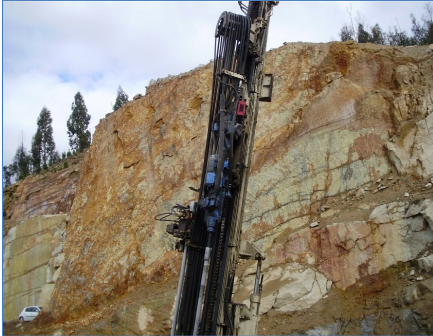
Figura 14 – Célula de recepção do feixe “laser” no equipamento de perfuração.
