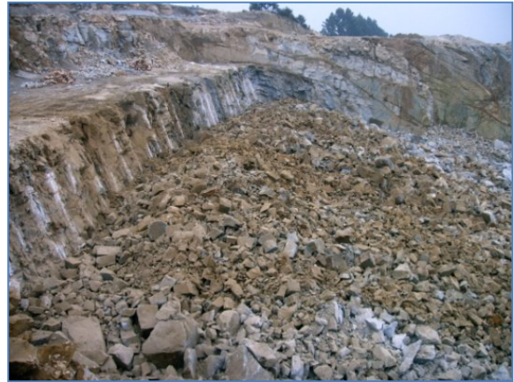
Figura 83 – Adequada temporização das diferentes fiadas de furos.
