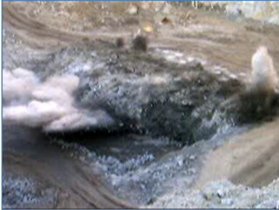
Figura 10 – Projecções resultantes na base da soleira em resultado dos desvios na direcção da frente livre.
