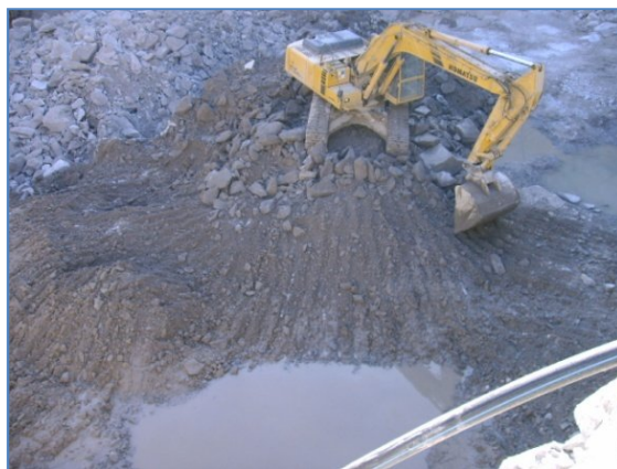
Figura 49 – Limpeza antes da perfuração seguinte com conseqüente afectação da zona superficial.
