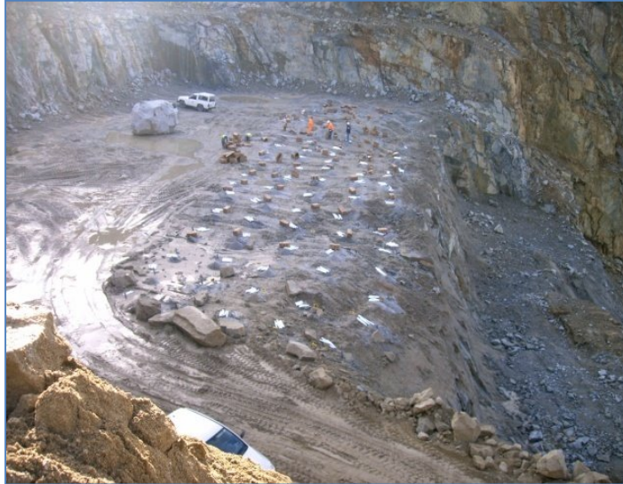
Figura 71 – Distribuição do explosivo e acessórios de detonação.
