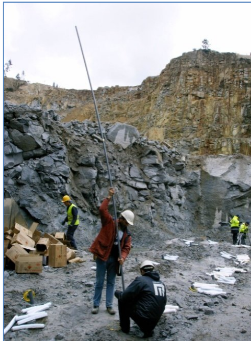
Figura 74 – Uso das varas de apoio ao carregamento para garantir o encosto dos cartuchos dentro do furo.
