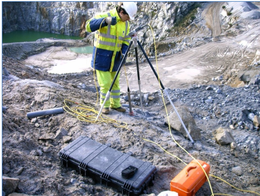
Figura 35 – Utilização do sistema de monitorização “boretrak”.
