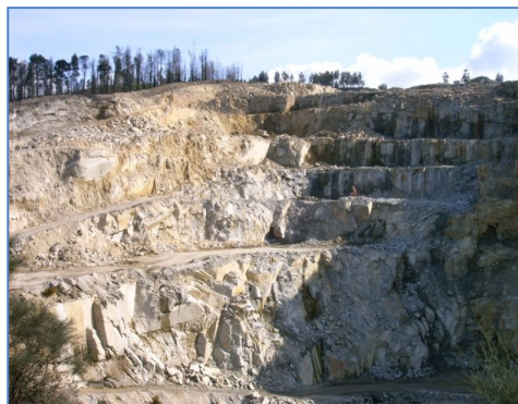
Figura 64 – Evolução dos trabalhos em flanco de encosta na zona B (vista inferior).
