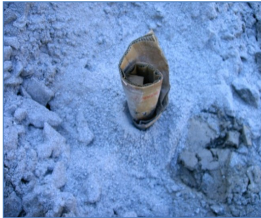
Figura 51 - Furos protegidos com cartão para evitar a queda de material.
