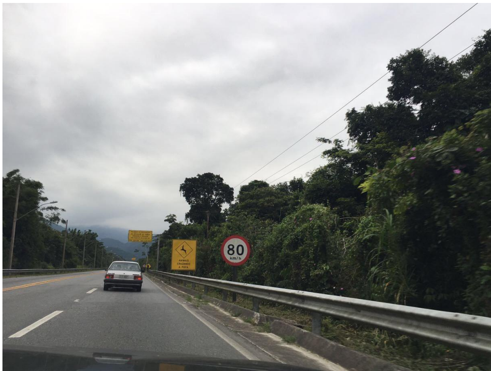
Figura 5.4 - SP-098 no Km 92
