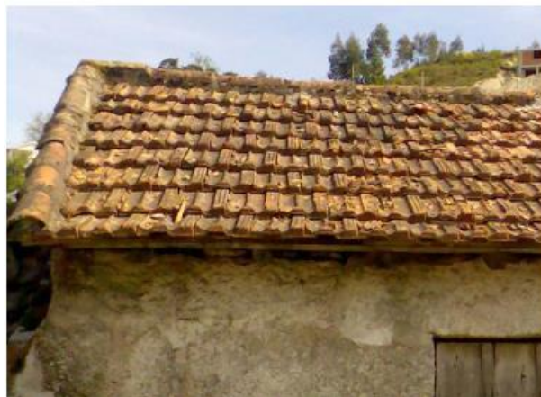
Figura 2.12 - Telhado em telha Marselha (Guimarães, 2009)
