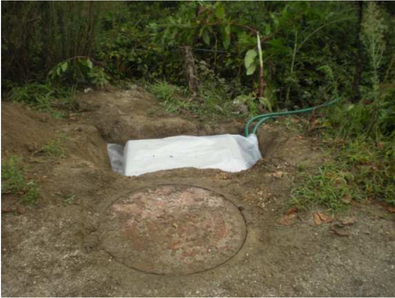
Imagem I.12 – Caixa fechada antes do aterro das terras.
