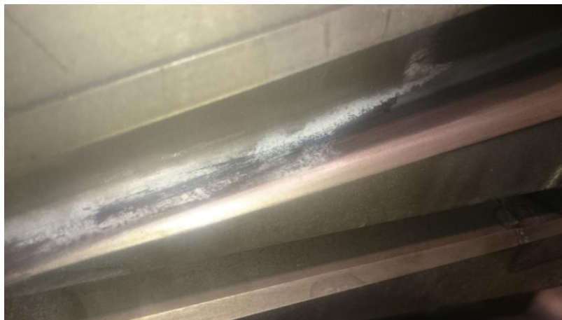
Figura 131 – Remoção do revestimento presente na parte móvel do cabeçote novo.
