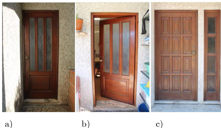
Figura 4.10 - Portas - a) da cozinha para o exterior (N), b) da cozinha para o espaço não aquecido - varanda (S), e c) do vestíbulo para o exterior (N).
