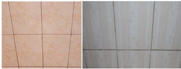
Figura 4.7 - Revestimento interior das paredes exteriores da cozinha (à esquerda) e dos quartos de banho (à direita).
