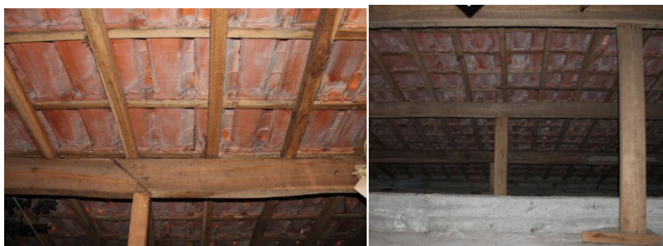
Figura 4.5 - Estrutura da cobertura e revestimento da cobertura.
