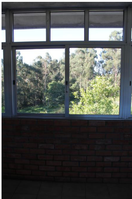
Figura 4.3 - Envoltente exterior do espaço não aquecido - varanda.
