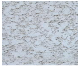
Figura 4.6 - Revestimento exterior das paredes exteriores.
